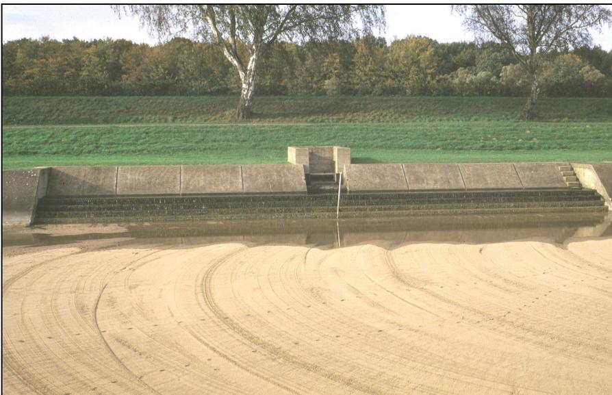
Abb. A3-10: Einlaufbauwerk des LSF 1 auf der Insel Hengsen mit Kaskaden zur Sauerstoffanreicherung von SO aus. Photo: D. Rüetschi.
