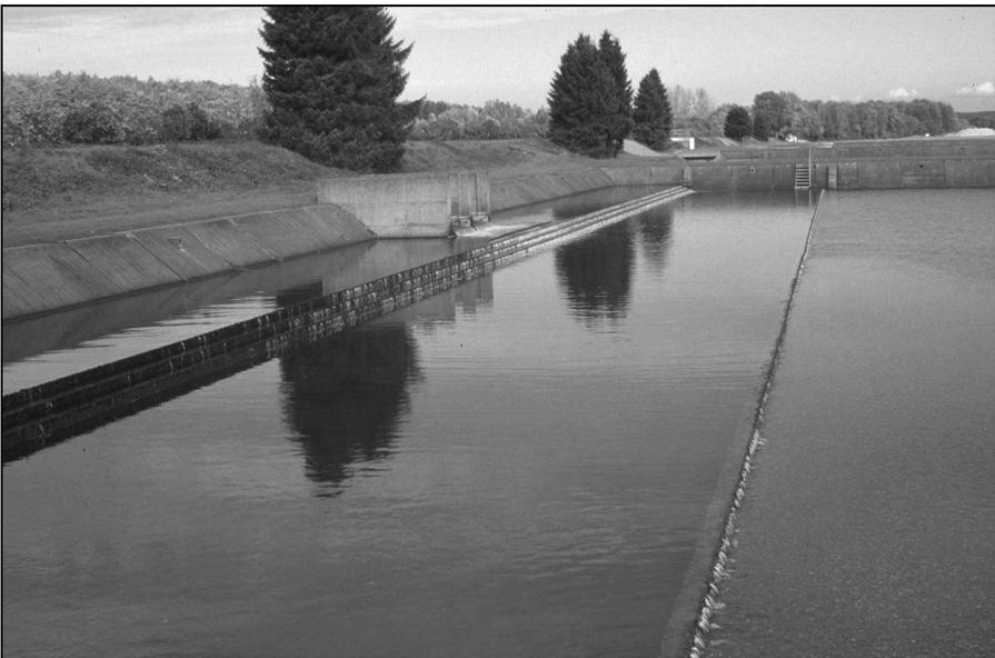
Abb. 4-10: Ansicht eines Kiesvorfilters von SW aus mit Einlaufbauwerk und Kas-kaden zur Sauerstoffanreicherung. Photo: D. Rüetschi.
