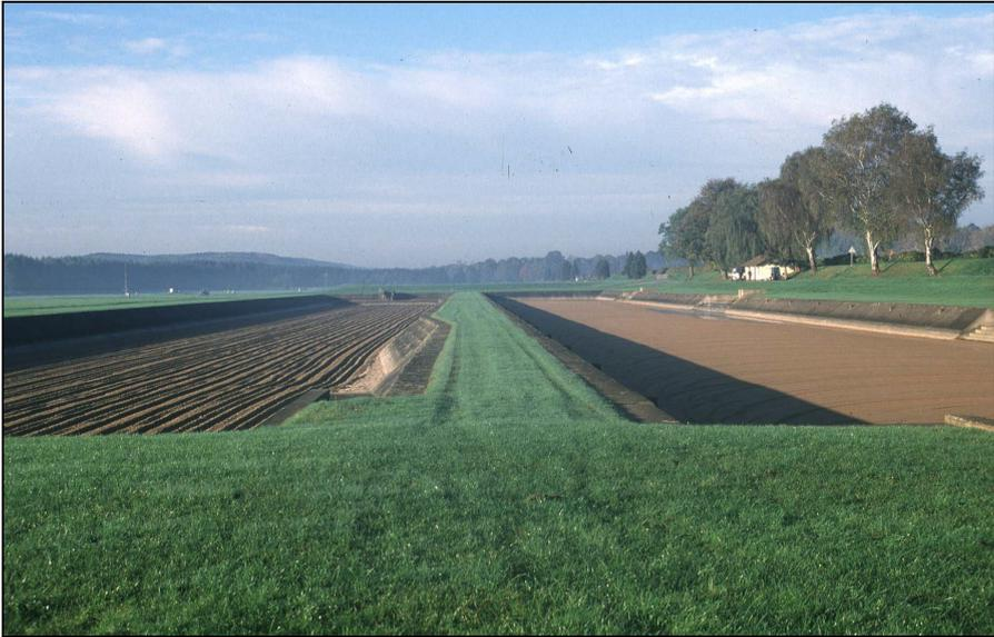
Abb. A3-9: Ansicht der Langsandsandfilter 1 (rechts) und 2 (links) auf der Insel Hengsen von NO aus. Beide LSF wurden frisch eingesandet. LSF 1 wurde bereits wieder in Betrieb genommen. Photo: D. Rüetschi.
