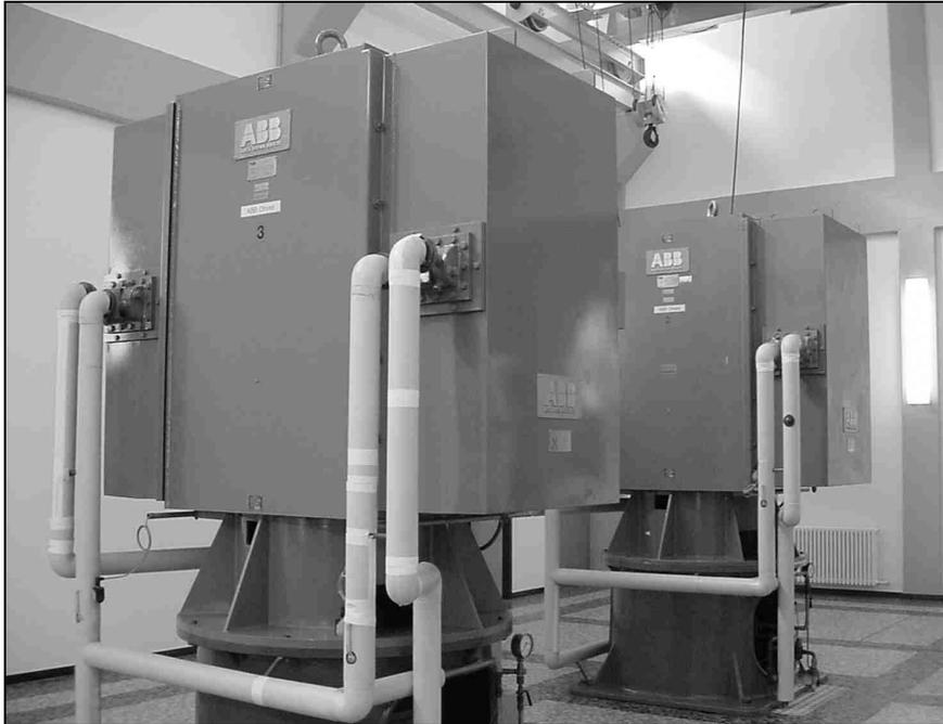
Abb. 1-18: Zwei der vier Hochdruckpumpen-Motoren, mit welchen das Trinkwasser in das städtische Leitungsnetz gefördert wird. Photo: D. Rüetschi.
