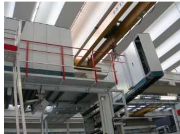
Foto 38. Trasporto quadri elettrici su mezzanino con carro ponte.
