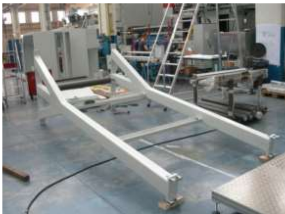
Foto 30. Premontaggio montanti a terra.
