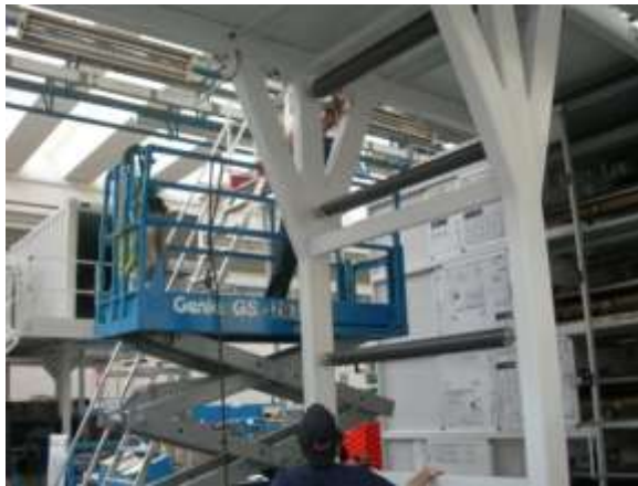
Foto 34. Allineamento montante sx alla struttura ponte.
