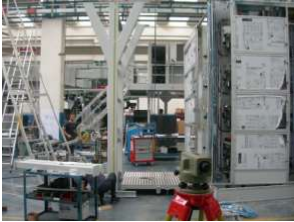
Foto 32. Allineamento struttura con utilizzo del collimatore.
