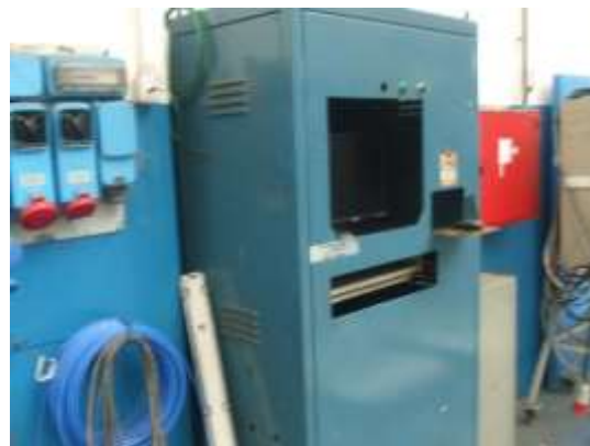
Foto 3. Postazione PC in campata.
