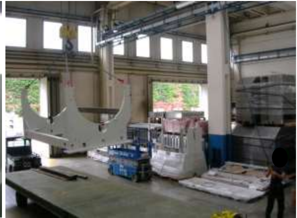
Foto 19. Trasporto spalle avvolgitore con carro ponte dal rimorchio alla cella di lavoro.
