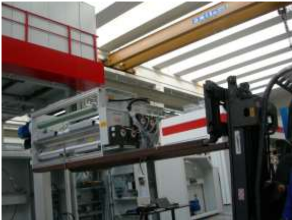
Foto 45. Posizionamento trattamento corona sotto il ponte macchina con utilizzo del muletto.
