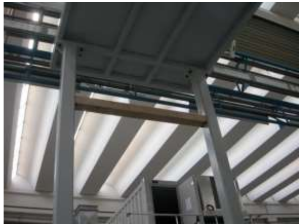
Foto 36. Traversa di legno temporanea.
