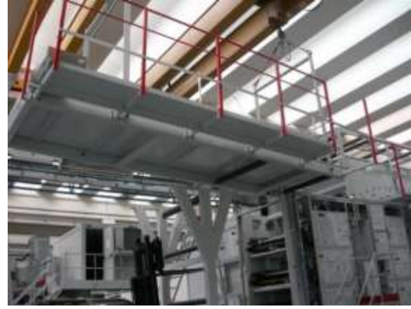
Foto 33. Posizionamento parte della struttura ponte sopra montante sx.
