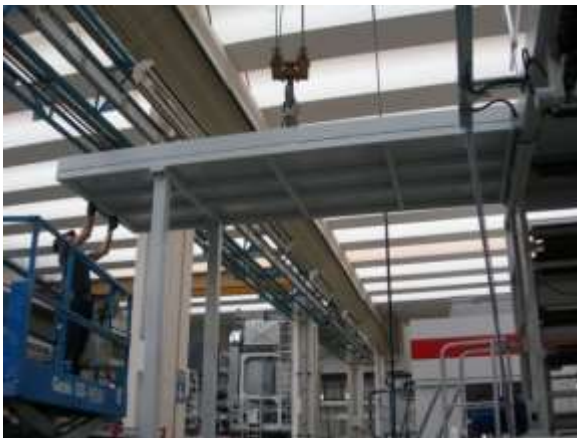
Foto 37. Posizionamento mezzanino su montanti.
