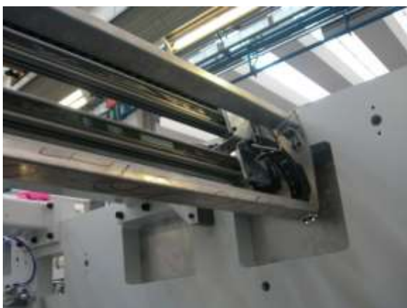
Foto 49. Movimentazione doppio controllo registro montato in macchina.
