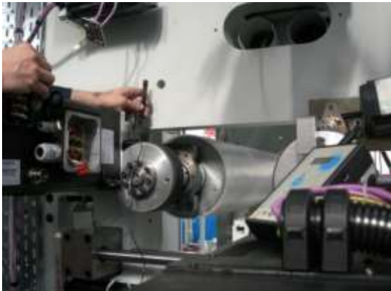
Foto 81. Tensionamento cinghie con strumenti di misurazione di frequenza.
