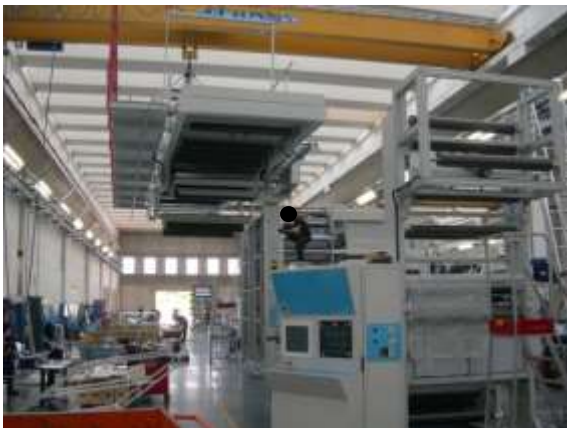
Foto 57. Trasporto gruppo ponte con carro ponte sopra la macchina.
