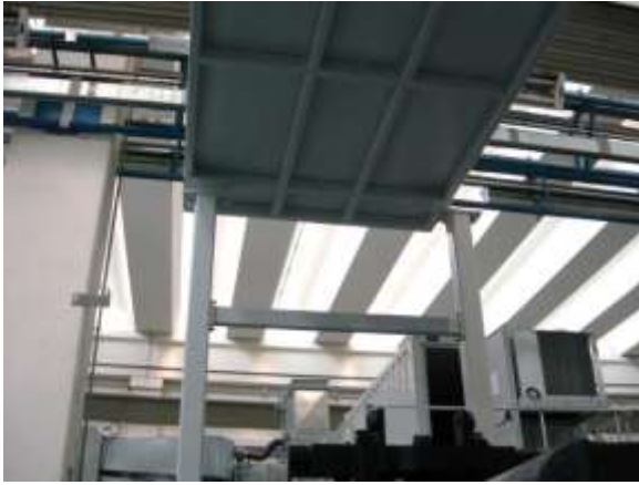
Foto 35. Traversa montanti fornita più lunga del necessario.
