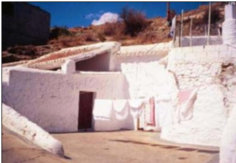
Ilustración 6. Fachada de vivienda troglodita en Fonelas.
