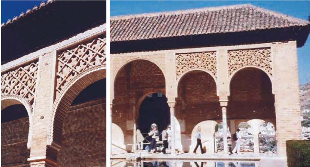
Figura 3.10. Detalle y vista general de la solución constructiva adoptada en el Partal, que coincide con la adoptada en la columnata del Patio de los Leones.
