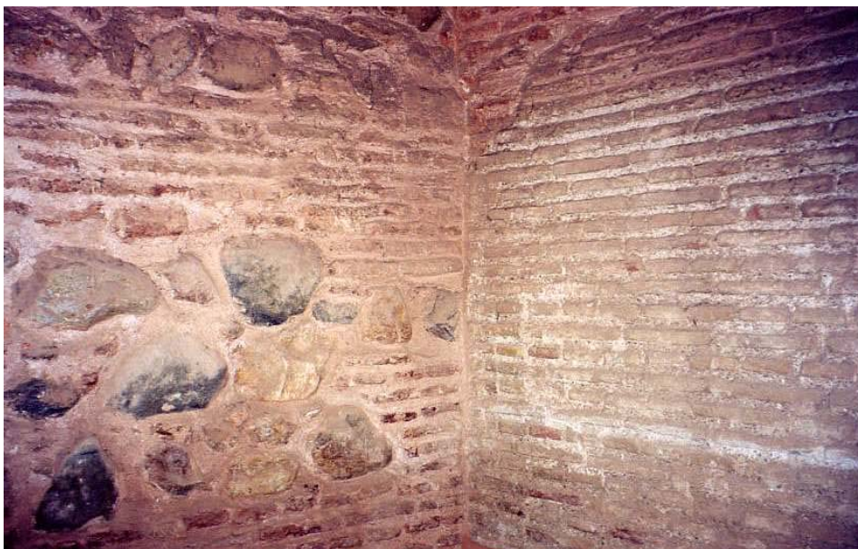
Figura 3.8. Detalle de la composición de los muros del Palacio en la planta sótano bajo la Sala de Dos Hermanas (ladrillo y mampostería).
