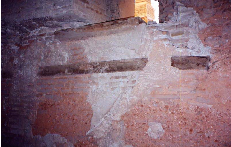
Figura 3.7. Detalle de la composición de los muros del Palacio en planta baja (ladrillo y tapial).
