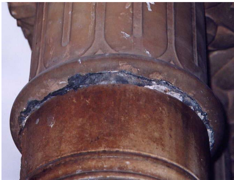
Figura 3.3. Detalle de chapa de plomo colocada entre la columna y el capitel.
