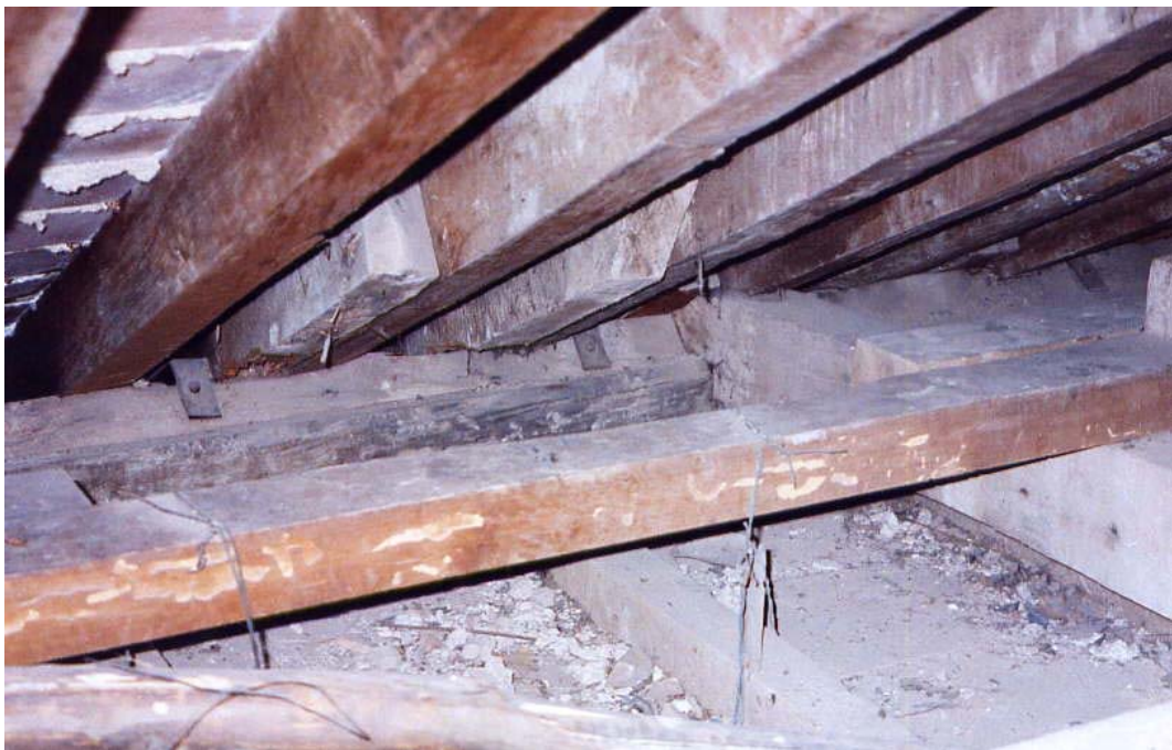
Figura 3.4. Detalle de la composición del forjado de madera del alero de las galerías perimetrales al Patio.
