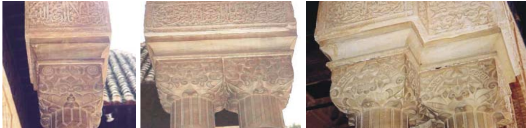
Figura 3.2. Detalle de la disposición de los capiteles en las distintas agrupaciones de 1, 2 y 3-4 columnas.
