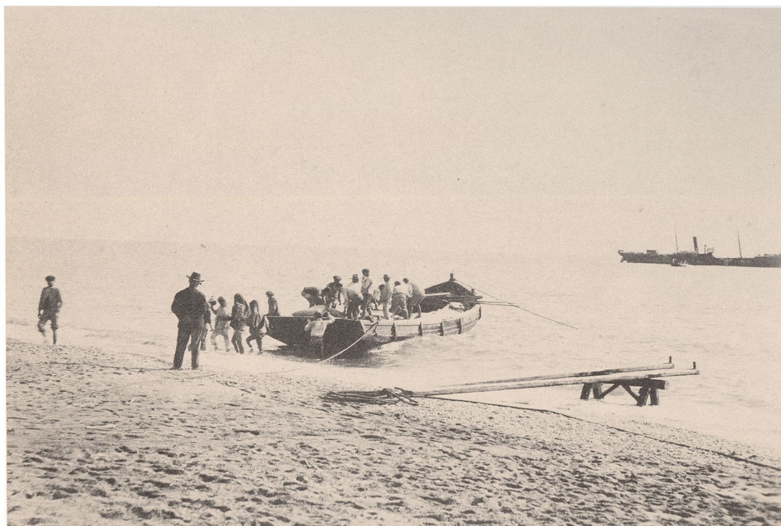
Figura 1.3: Rada del varadero de Motril. Las operaciones de carga y descarga, de mercancías, se efectuaban mediante barcazas. (Fuente González Ruiz, J. (Ed.), (1996.))
