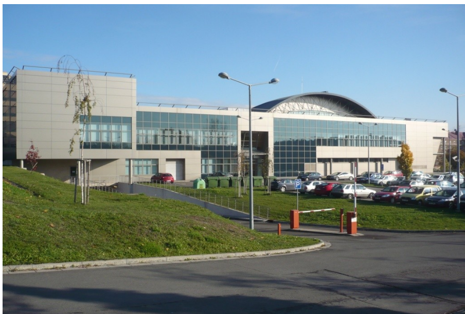
Obr. 8 Budova Auly na VŠB-TUO pohled západní
