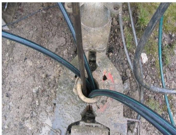
Obr. 15 Zavádění kolektoru do vrtů
