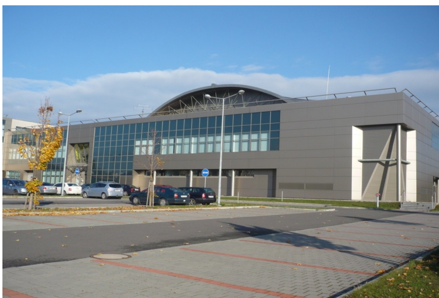
Obr. 7 Budova Auly na VŠB-TUO pohled jižní
