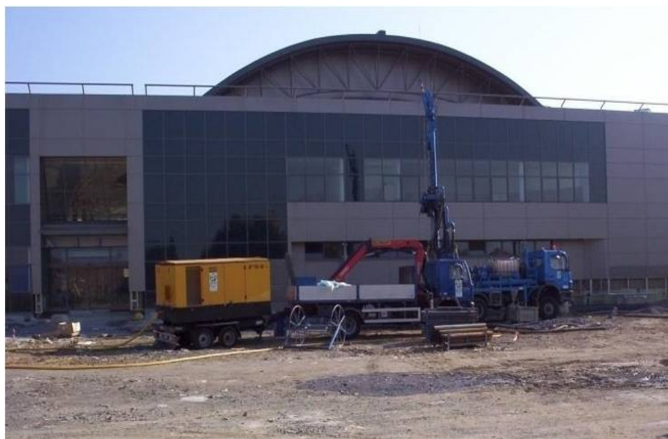
Obr. 18 Provádění vrtů v prostoru parkoviště Auly
