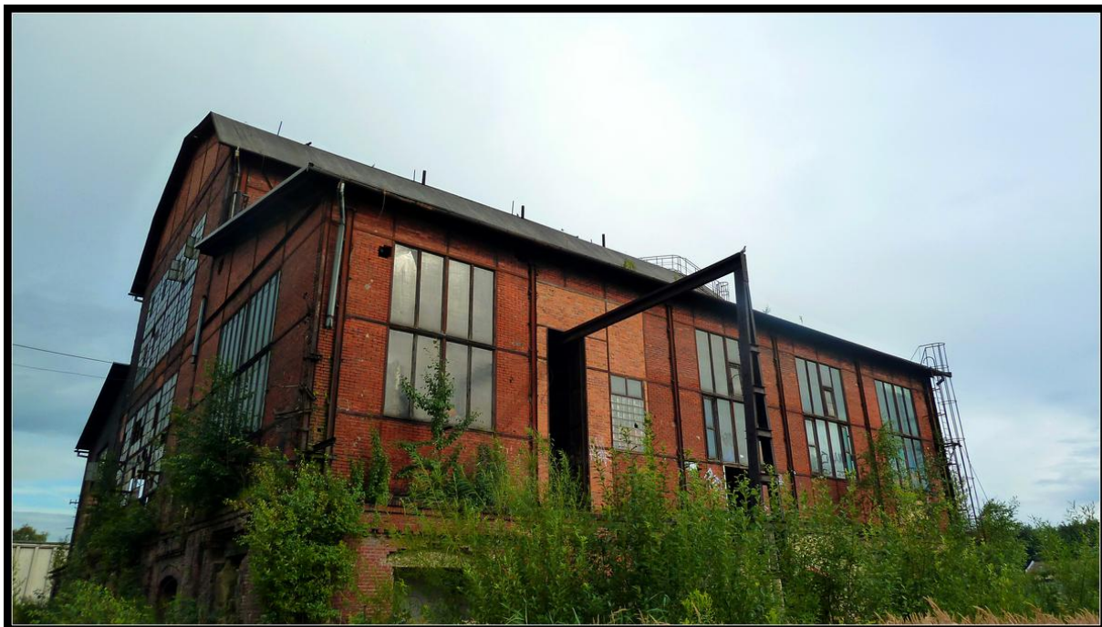
Obr. 3. – jedna z posledních staveb bývalého chemického závodu, která se na pozemku nachází
