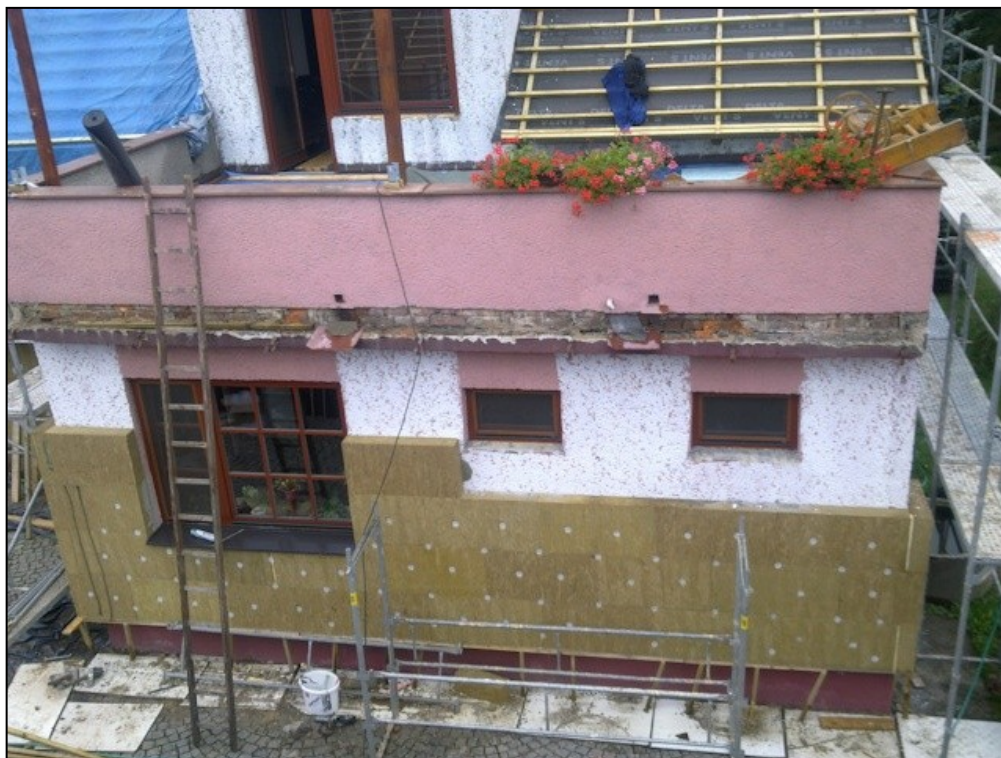
Obr. 9.2 Lepení a kotvení izolace na přístavbě RD
