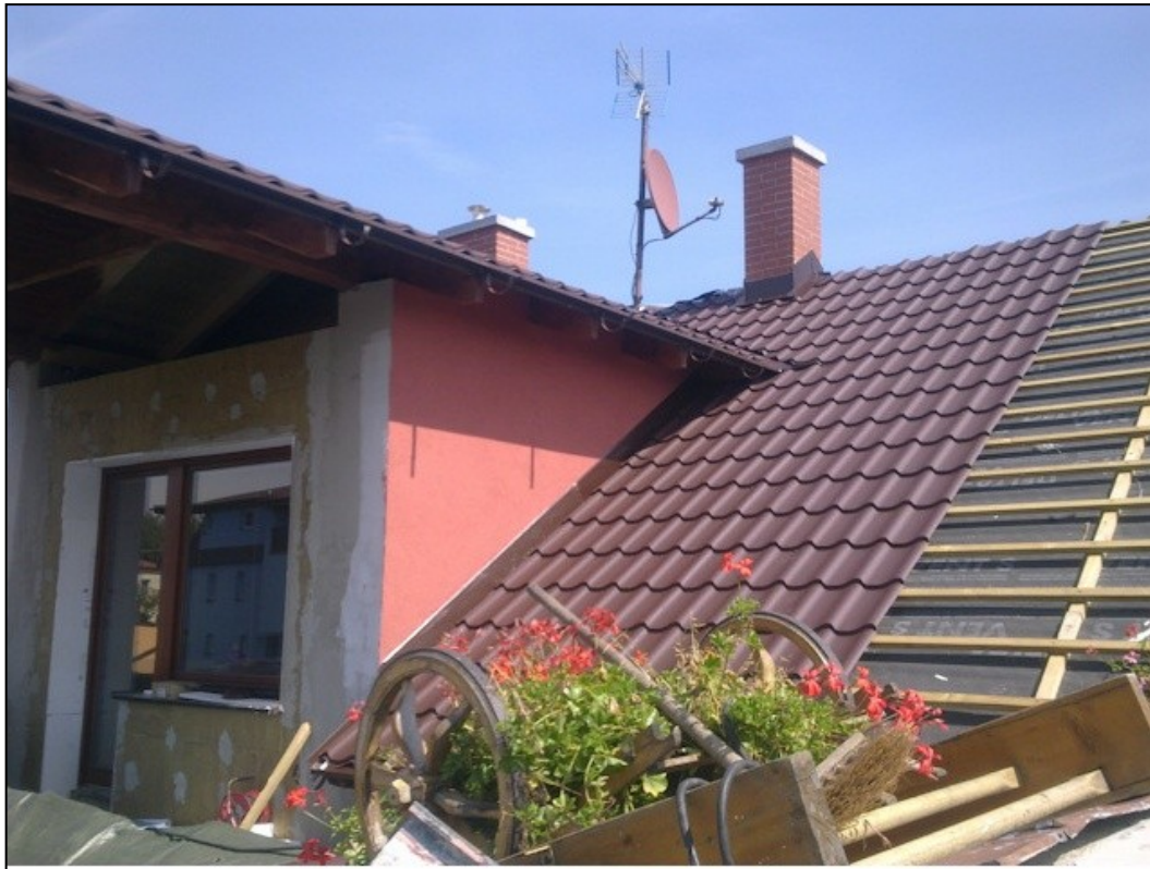
Obr. 9.6 Pokládání střešní krytiny
