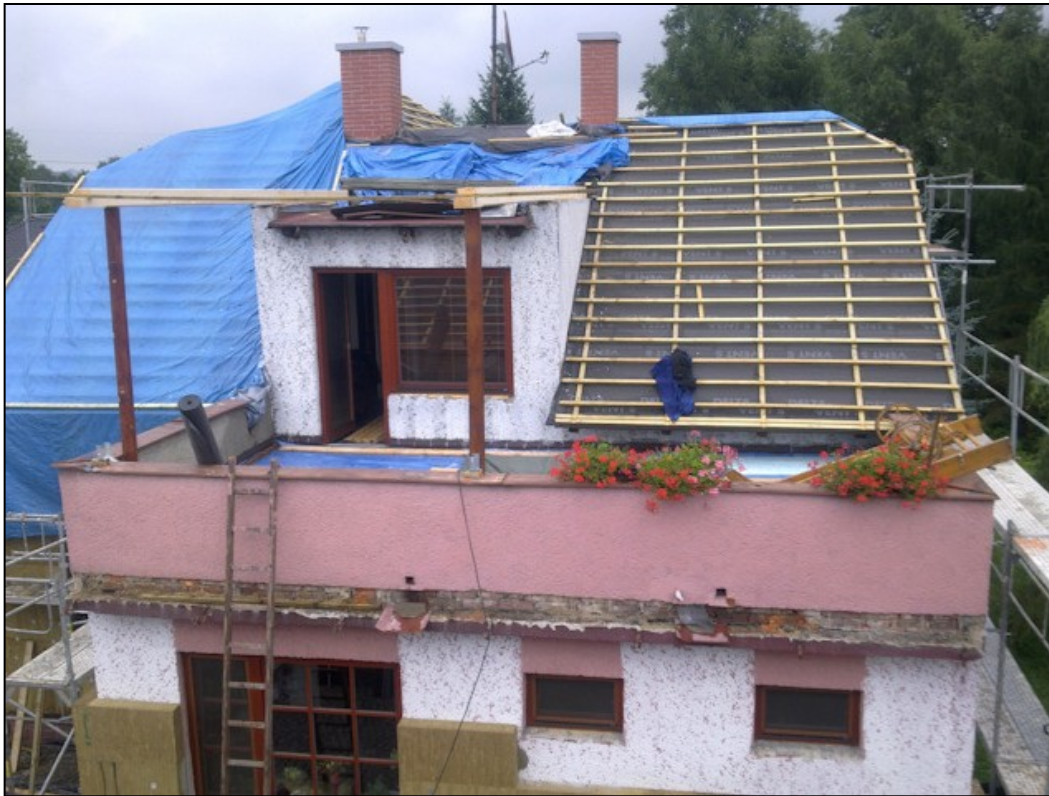
Obr. 9.1 Instalace latí na střešní krytinu, nátěr pentrací a lepení izolace
