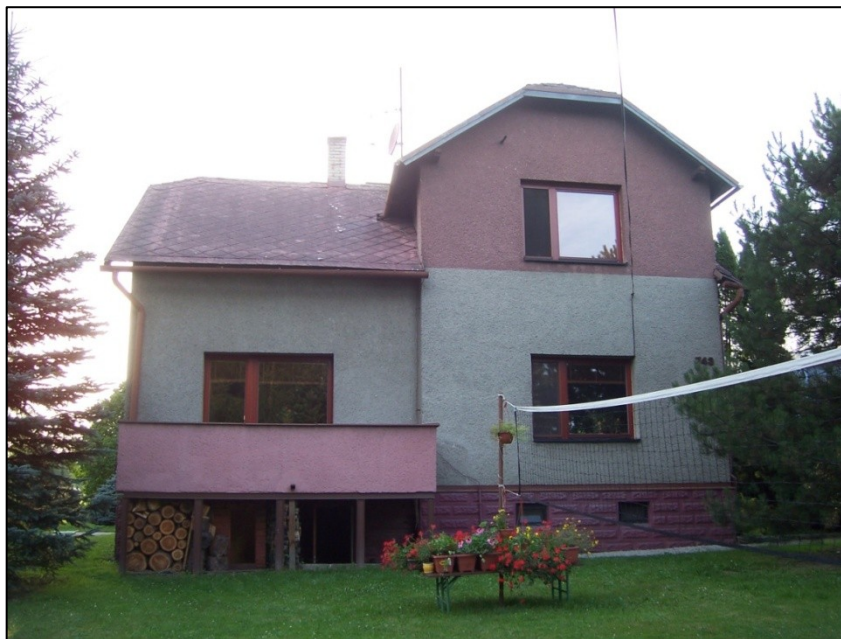
Obr. 3.1. Východní strana domu
