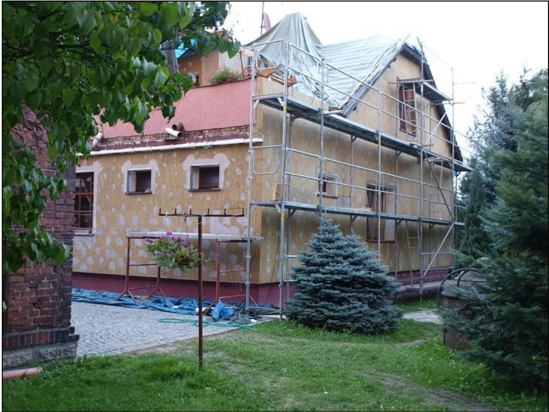
Obr. 9.4 Lepení a kotvení izolace na jižní straně RD
