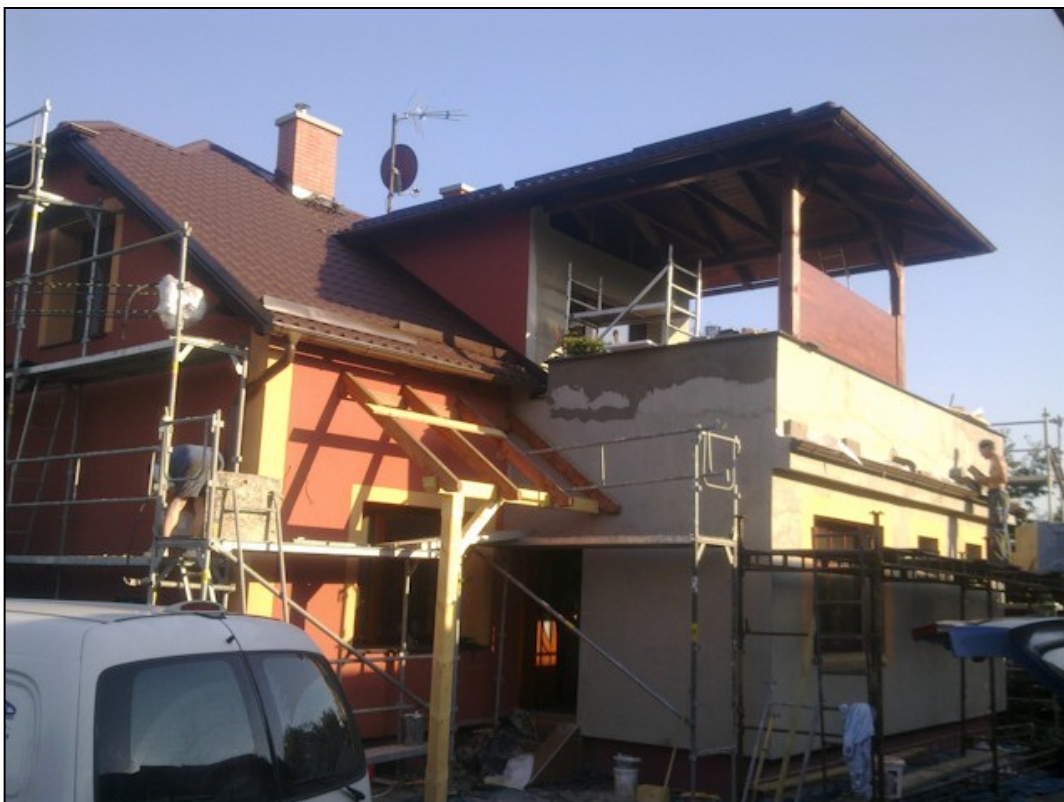
Obr. 9.7 Nanášení finální vrstvy omítky a stavba přístřešku nad hlavní vchod
