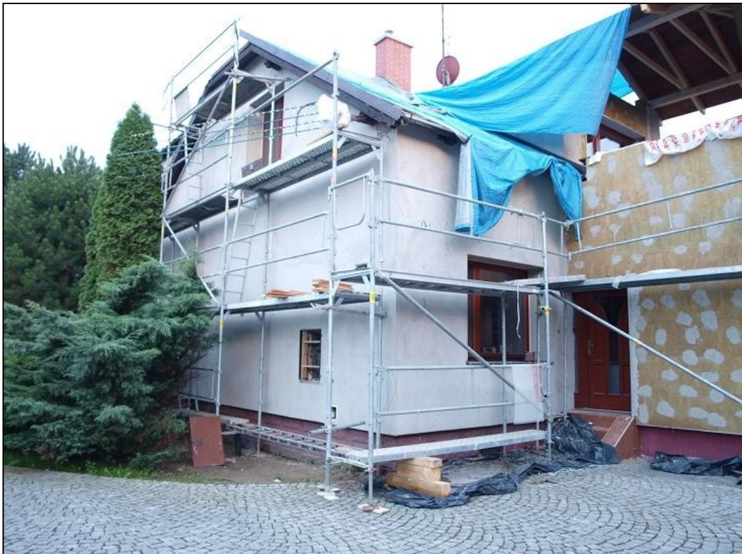
Obr. 9.5 Nanášení vrstvy na perlinku stěny
