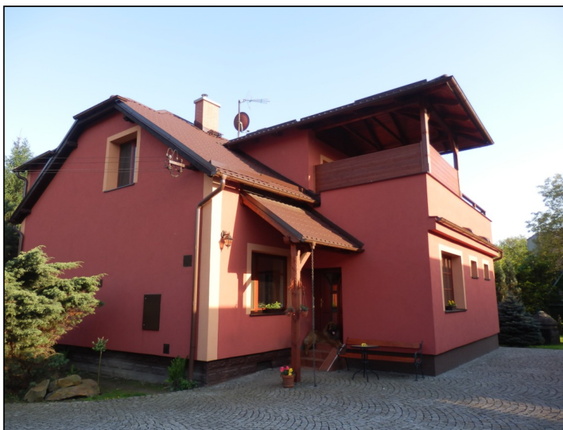
Obr. 8.3 Nová podoba rodinného domu po rekonstrukci
