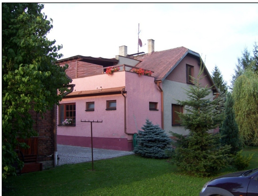
Obr. 3.2. Pohled na jižní (vpravo) stranu domu
