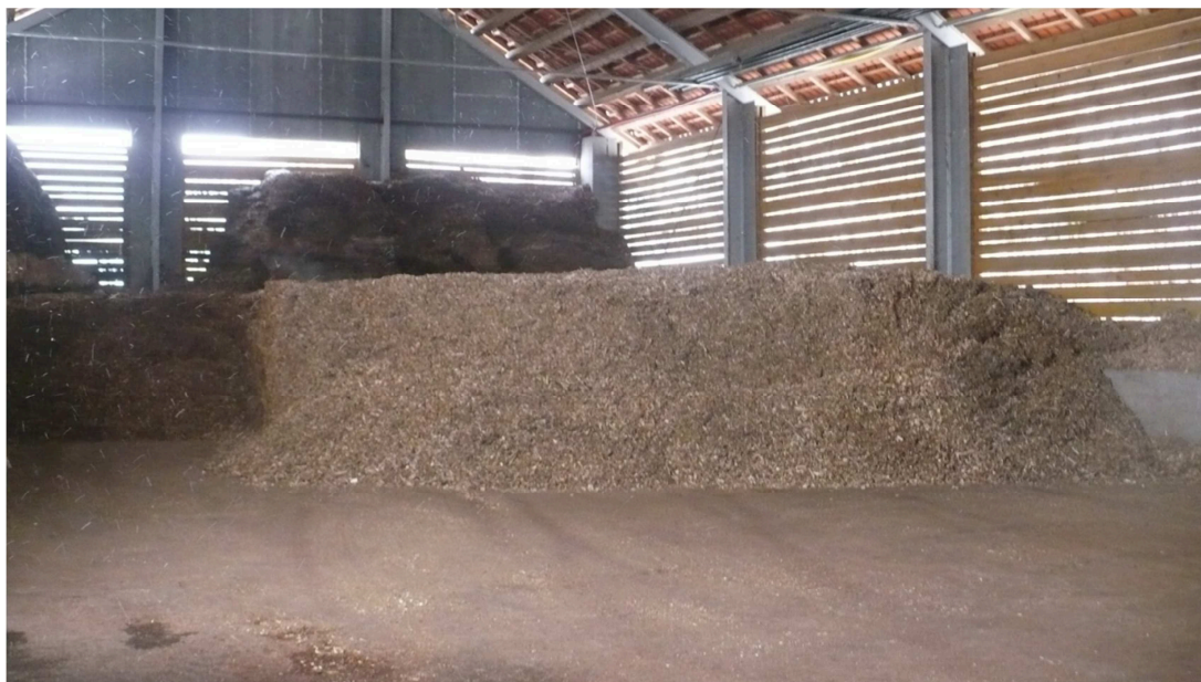
Obrázek 4: Skladování dřevní štěpky v Hostětínské výtopně (foto: Sabina Divilová, duben, 2013)
