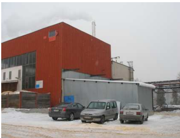
Obrázek 6: Biomasová kotelna s instalovaným výkonem 3,5 MW po modernizaci [35]
