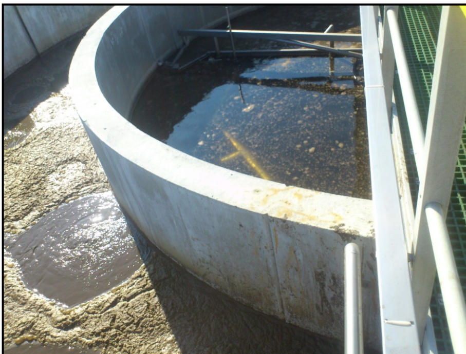
Obrázek 13: Biologická linka 2, aktivace a dosazovací nádrž (Maráková, 2013)
