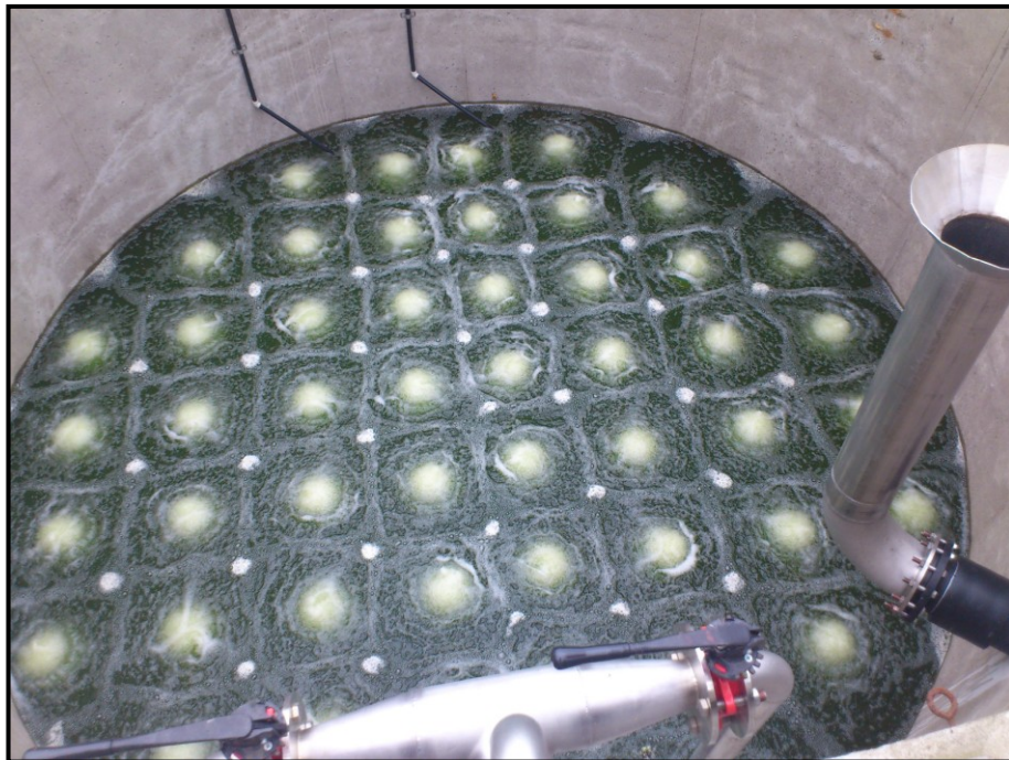
Obrázek 11: Jemnobublinný aerační systém a aktivační nádrž 1 těsně po montáži (Maráková, 2013)
