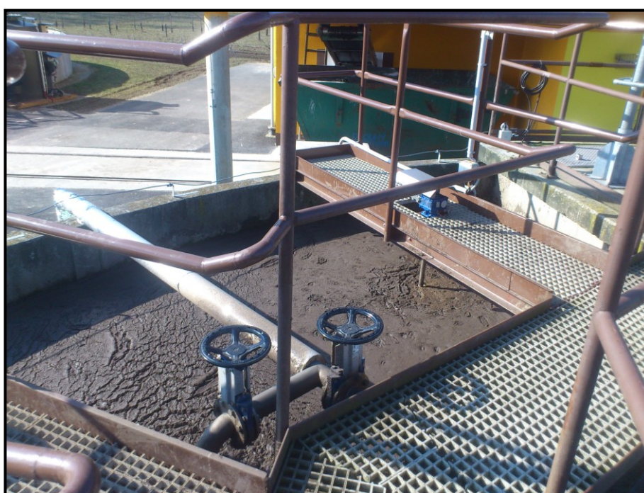
Obrázek 10: Nádrž denitrifikaci po zapracování v systému (Maráková, 2013)
