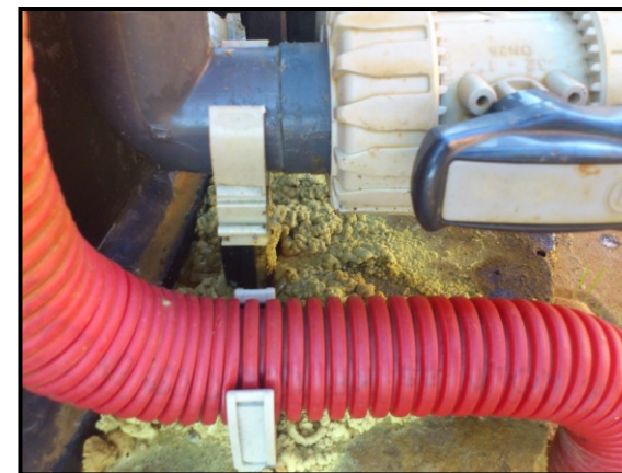
Obrázek 17: Netěsnost nádrže na \text{Fe}_2\text{SO}_4^- (Maráková, 2013)
