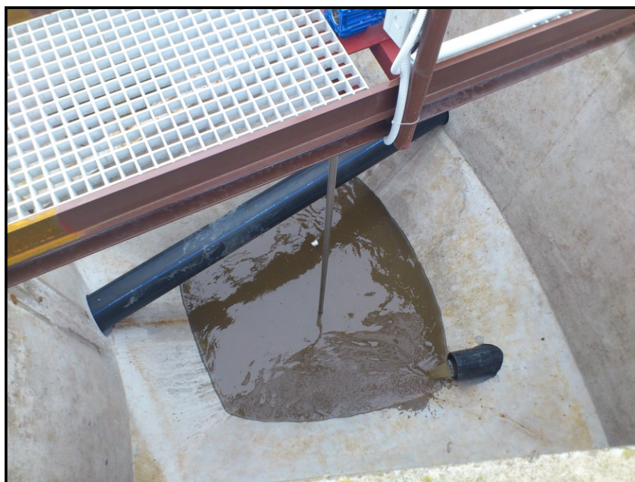
Obrázek 9: Nádrž denitrifikace při výstavbě (Maráková, 2013)
