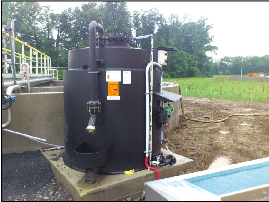
Obrázek 14: Nádrž síranu železité při výstavbě ČOV (Maráková, 2012)
