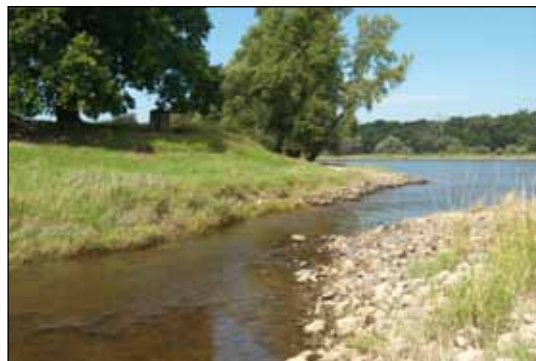
Abb. 2: Ökologischer Umbau von Flussbauwerken - ein Leitwerk mit Durchströmungsöffnungen (Elbe-km 250,0 - linkes Ufer). Foto: A. Regner.
