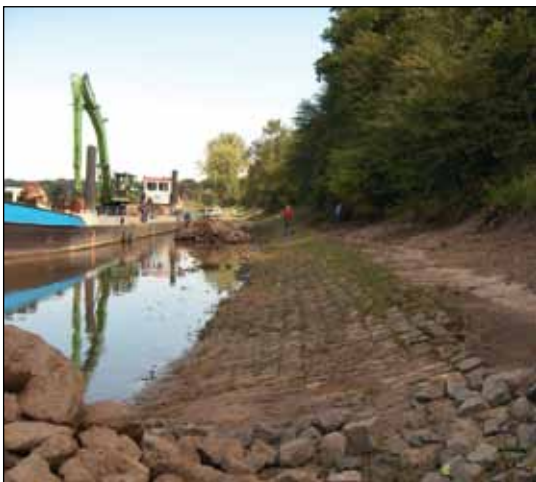
Abb. 6: Rückbau eines Deckwerkes bis zur Mittelwasserlinie am Matzwerder (Elbe-km 249,4 - rechte Elbeseite) während der Maßnahme. Foto: A. Regner.
