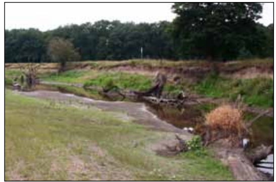
Abb. 3: Initiierte Uferabbrüche hinter einem Leitwerk, Matzwerder (Elbe-km 249,4 - linke Elbeseite). Foto: G. Puhlmann.
