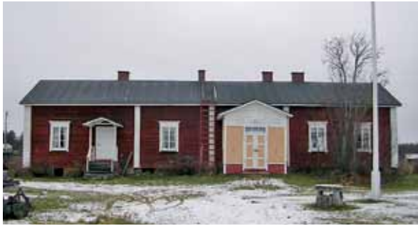
Kuva 133. Mettjäisen päärakennus. LKYT 2004.
