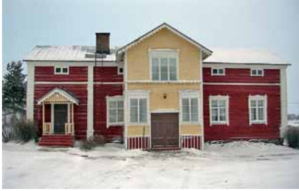
Kuva 74. Talvensaaren päärakennus. LKYT 2004.
