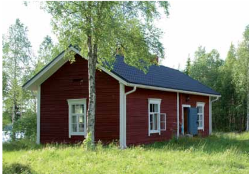
Kuva 63. Marilan asuinrakennus. Tiina Elo 2011.
