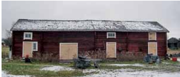
Kuva 134. Mettjäisen makasiini-talli-liiteri –rakennus. LKYT 2004.
