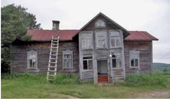
Kuva 56. Lehtolan päärakennus. LKYT 2005.
