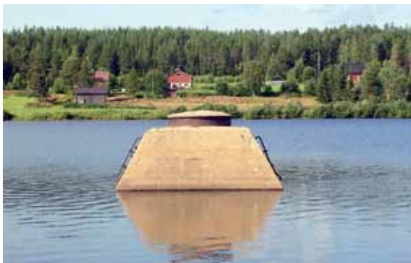
Kuva 172. Autioniemen uiton vastuun kiinnityspilarit on jätetty muistoksi uiton suuresta merkityksestä alueelle. LKYT 2005.
