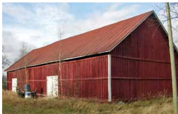
Kuva 173. Autioniemessä on jäljellä vielä myös uiton aikaista rakennuskantaa. LKYT 2005.
