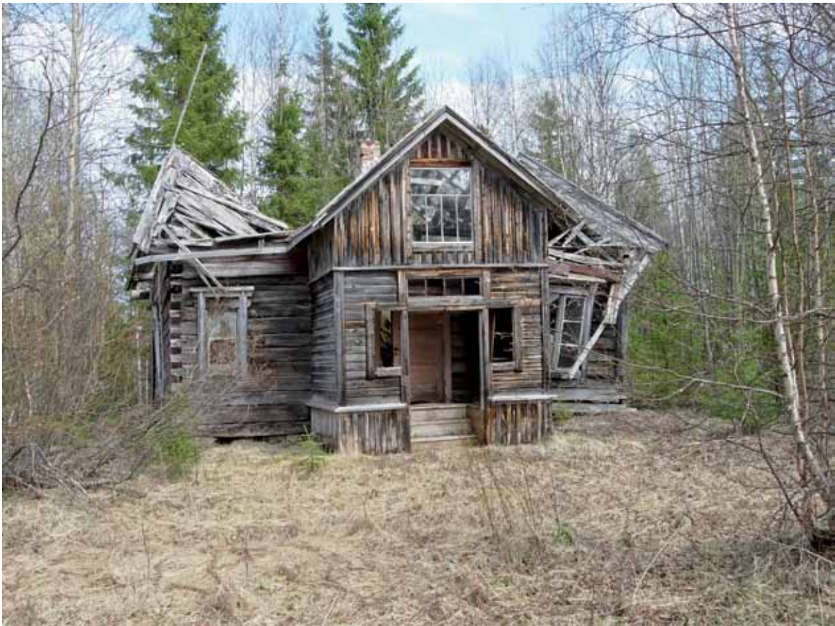
Kuva 194. Käyttöä vaille jääneet rakennukset menevät ennen pitkää huonoon kuntoon. Simo Oinas 2009.
