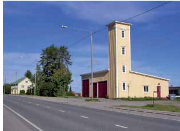
Kuva 32. Paloasema sijaitsee Pelkosenniemen valtakunnallisestikin arvokkaassa kirkonkylän kulttuurimaisemassa. LKYT 2004.
