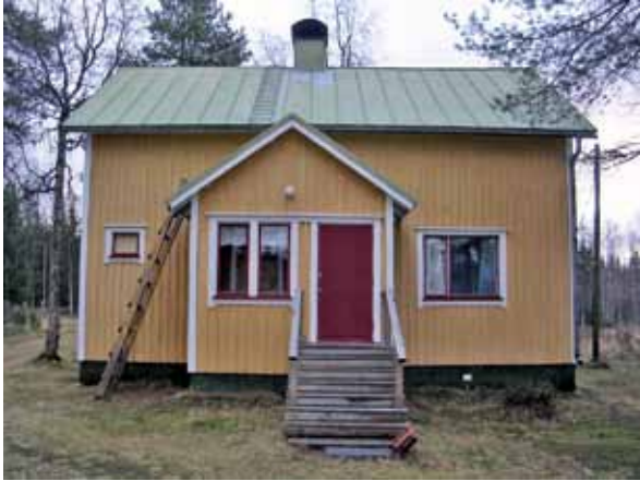
Kuva 27. Lepolan päärakennus Saukkoavalla. LKYT 2005.
