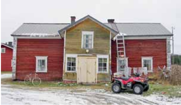
Kuva 129. Hiltusen päärakennus. LKYT 2004.
