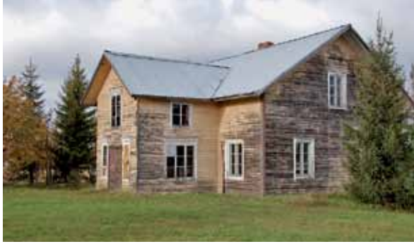
Kuva 44. Tuppukylän päärakennus vuonna 2009. Kohdetta remontoidaan parhaillaan. Tiina Elo 2009.
