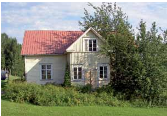
Kuva 80. Kantolan päärakennus. LKYT 2005.
