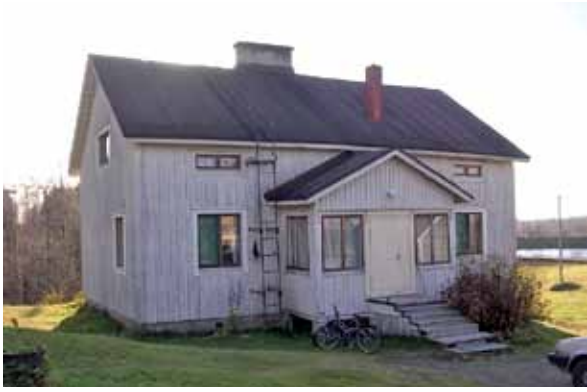
Kuva 25. Salmelan asuinrakennus Kairalan kylässä edustaa tyyppillistä jälleenrakennusajan tyyppitaloa kaksijakoisine standardi-ikkunoineen ja lautavuorattuine julkisivuineen. LKYT 2005.
