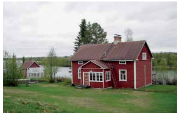
Kuva 24. Lapissa tyyppitalot saatettiin rakentaa vielä hirsirunkoisina ja vuoraamattomina. Etelämpänä kaikki tyyppitalot tehtiin rankorakenteisina. Kuvassa olevassa Yli-talon päärakennuksessa on myös jälleenrakennuskaudelle epätyypilliset ikkunat eli 1880-luvulta aina 1920-luvulle käytössä olleet T-ikkunat. Lapissa tätä mallia käytettiin jonkun verran myös jälleenrakennuskauden tyyppitaloissa, joihin yleensä tehtiin kaksijakoiset standardi-ikkunat. Lapin oloissa tyyppitaloihin sallittiin enemmän poikkeuksia ja paikallisia sovelluksia kuin etelän taajamissa. Simo Oinas 2009.
