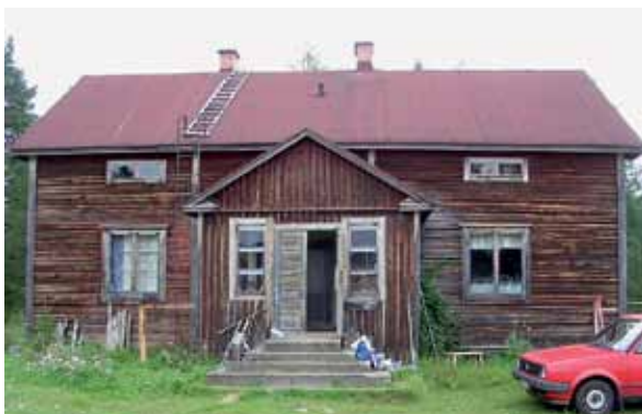
Kuva 144. Vittikon päärakennus. LKYT 2005.
