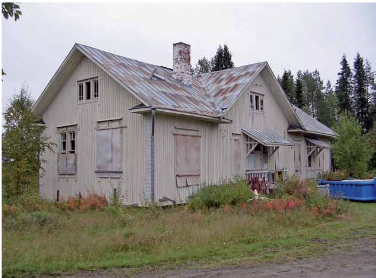
Kuva 157. Pelkosenniemen kirkonkylän vanha koulu rakennettiin Alaperän kansakouluksi vuonna 1910. Rakennus myytiin vuonna 2002 ja vuonna 2004 se purettiin muualle siirrettäväksi. LKYT 2004.
