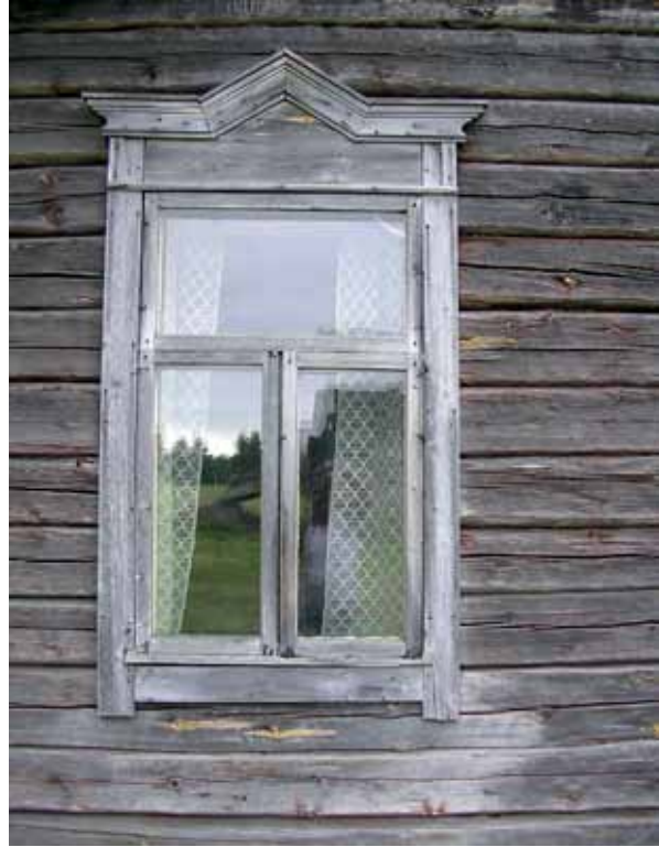
Kuva 58. Lehtolan päärakennuksen ikkuna. LKYT 2005.
