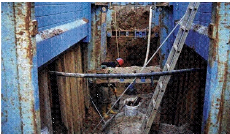
Figura 27 - Blindaggio con cassero porta-palancole (foto)
