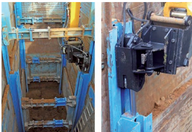
Figura 21 - Blindaggio con accoppiamento di due unità di blindaggio per grosse profondità (foto)
