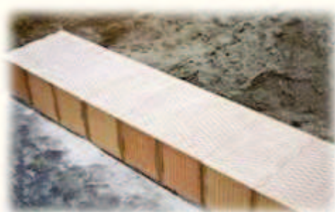
Obr. č. 8 – Zасыпání první řady zdiva HELUZ perlitem 7
