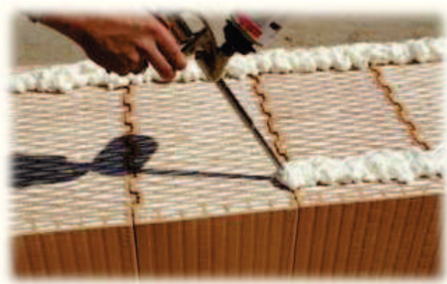
Obr. č. 9 – Aplikace montážní pěny HELUZ 8
