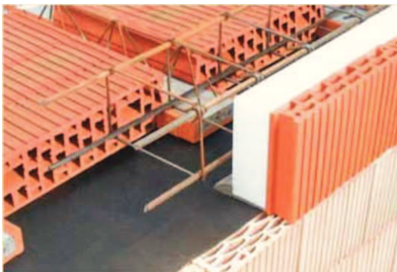
Obr. č. 17 – Příprava ŽB věnce stropu HELUZ 16
