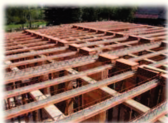
Obr. č. 20 – Příprava osazení stropních vložek HELUZ 19
