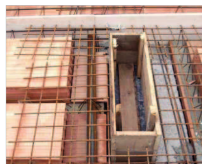
výměna u prostupu stropem pomocí vloženého úhelníku 75/50/6
