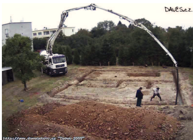
Obr. 4 Betonování základů [6]
