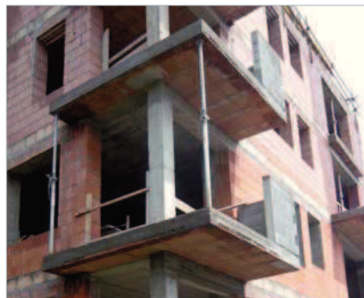
rohový balkón s přidanou výztuží
