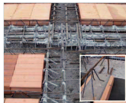
uložení trámečků do železobetonového průvlastku
