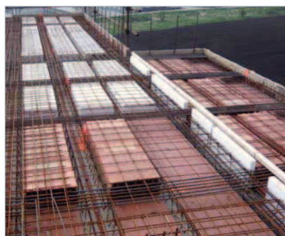
přerušení tepelného mostu mezi balkónem a stropem
