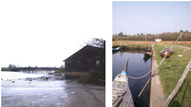
Exemplos de cais a recuperar
