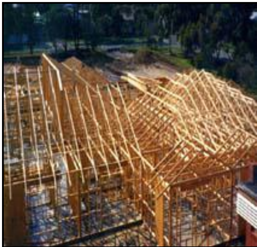
Rajah 2.6 Sistem Kerangka Kayu Pra-Siap
