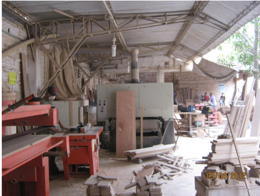
Figura 29. Adecuación de la zona de corte y lijado
