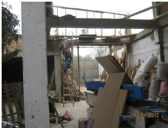
Figura 28. Construcción de la nueva Bodega de madera
