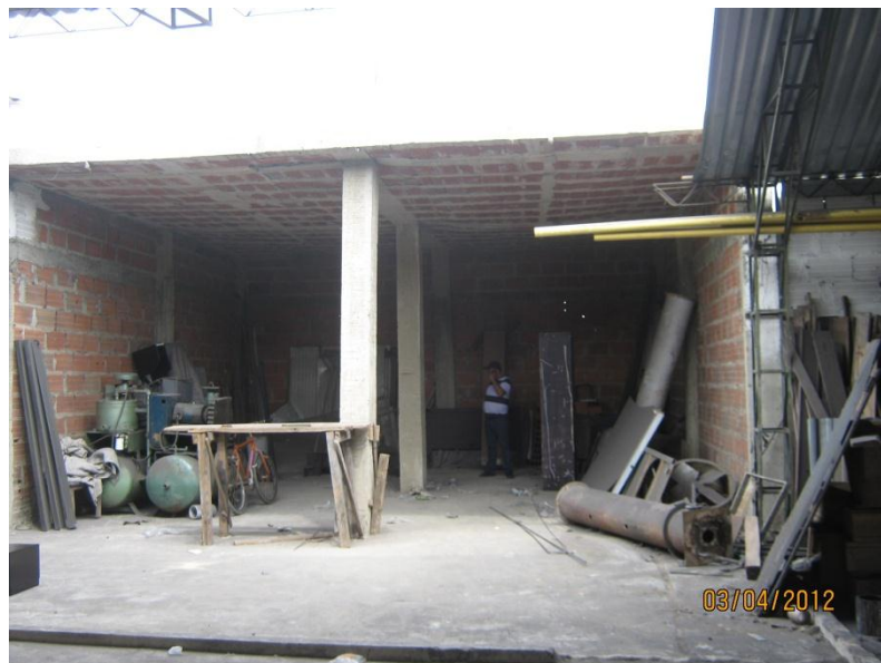
Figura 33. Adecuación de un área subutilizada para la ubicación de un Horno
