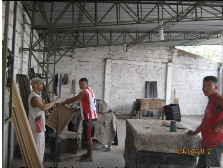
Figura 31. Adecuación de la zona de preparación
