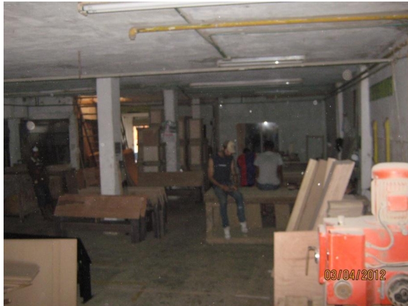
Figura 32. Ampliación de la zona de Armado
