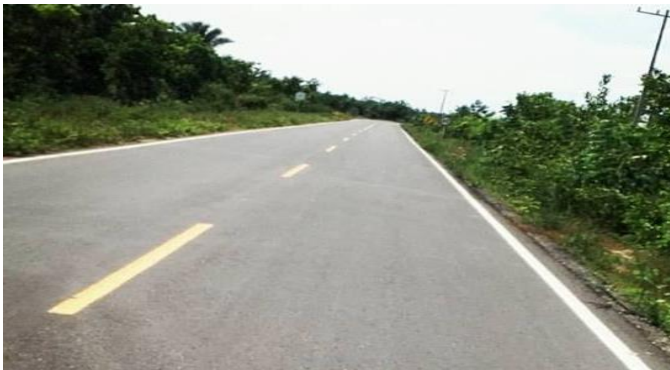
Figura 4. Pavimento flexible. Vía terciaria que comunica el municipio de La Jagua con el corregimiento de la Victoria. Por A. Lasso, 2017.
