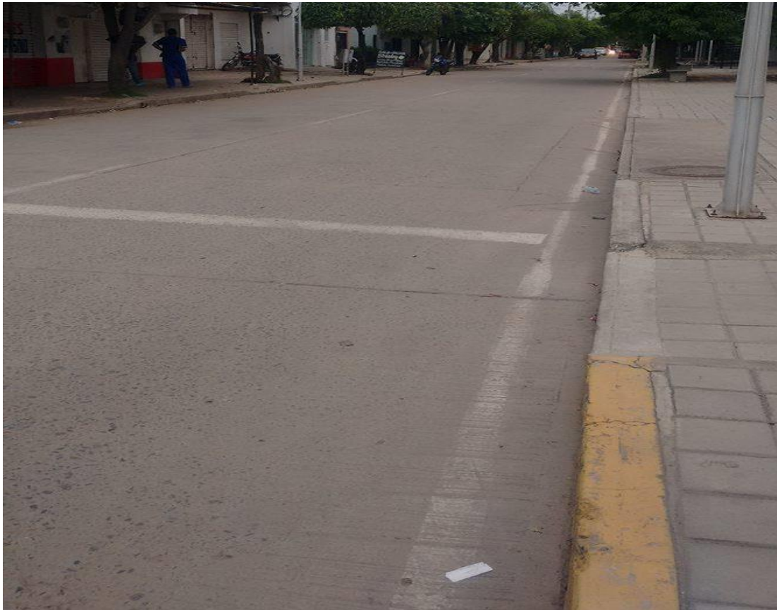
Figura 3. Pavimento rígido. Representación del pavimento rígido de la carrera 4 en el municipio de La Jagua de Ibirico. Por A. Lasso, 2017.
