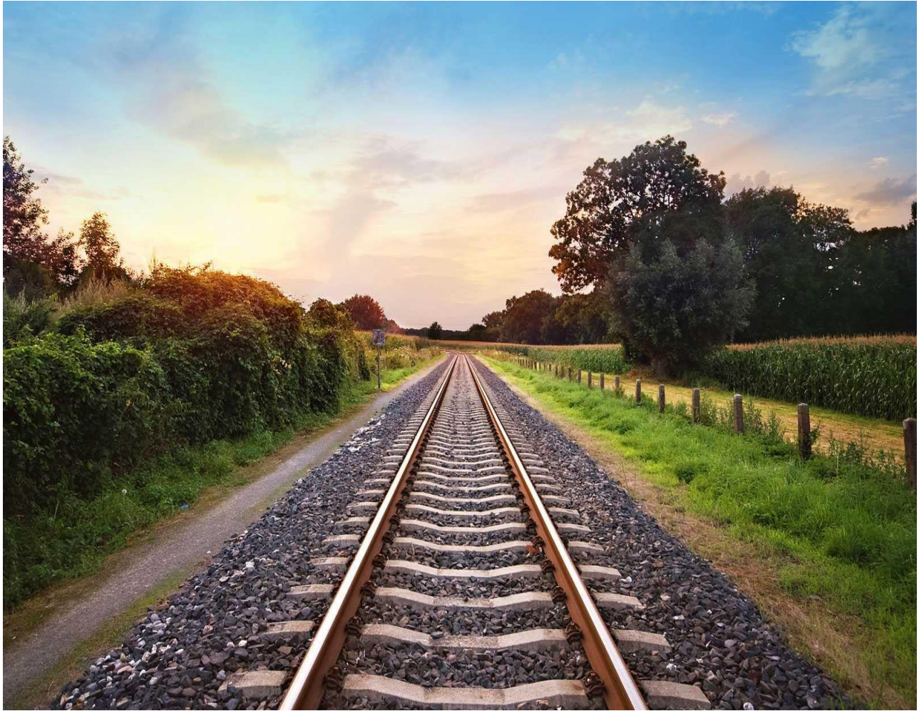
Figura 6. Vía férrea. Transitada únicamente por trenes en Colombia los que utilizan constantemente este medio de transporte son las empresas mineras explotadoras de carbón. Recuperado de https://sp.depositphotos.com/9932726/stock-photo-railway-track-in-perspective.html
