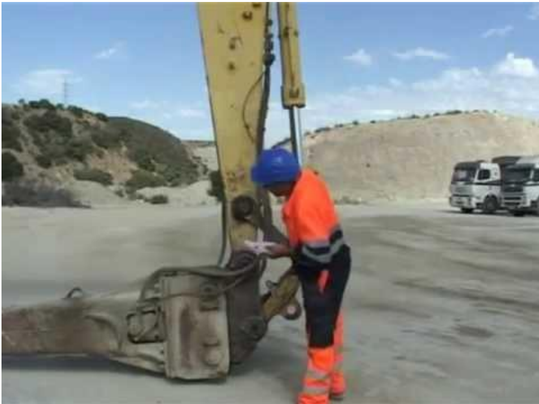
Figura 6. Presentación de mantenimientos rutinarios en obra. Recuperado de https://i.ytimg.com/vi/6e9XiDmj7MA/hqdefault.jpg
