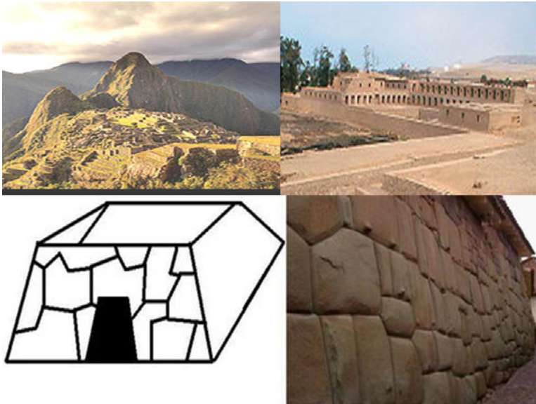
Figura 1.15. Machu Picchu como ejemplo representativo de la arquitectura inca sismoresistente (izquierda superior) Palacio Acllahuasi en Pachacámac (derecha superior). Casa de piedra (inferior), (Fuentes: http://es.wikipedia.org/wiki/Imperio_incaico ; http://historia.mforos.com/720862/6628455-construccion-antisismica-en-el-imperio )
