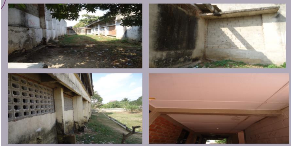
Figura 15.7 Espacios interiores y exteriores de colegio IETISA. Fuente: tomadas en el sector por Isaías Medina
