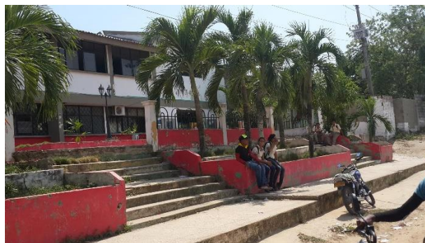
Figura 10.9 Edificio IETISA existente. Por: I. Medina
