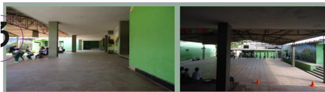
Figura 15.4 Espacios interiores y exteriores de colegio IETISA. Fuente: tomadas en el sector por Isaías Medina
