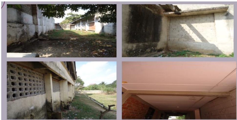
Figura 27.6 Espacios interiores y exteriores de colegio IETISA. Fuente: tomadas en el sector por Isaías Medina
