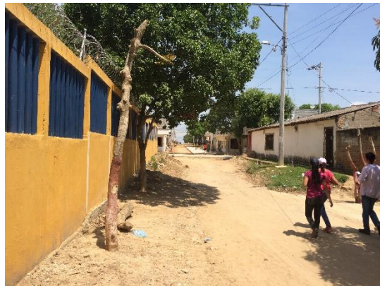
Figura 10.8 Edificio SENA. Por: I. Medina
