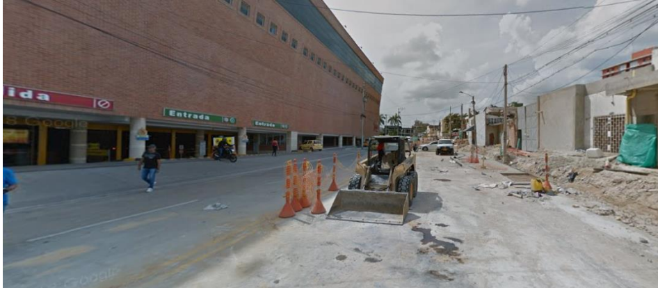
Figura 7. Acceso y Salida Zona de Parquaderos Cra. 50. Recuperado de Google Maps
