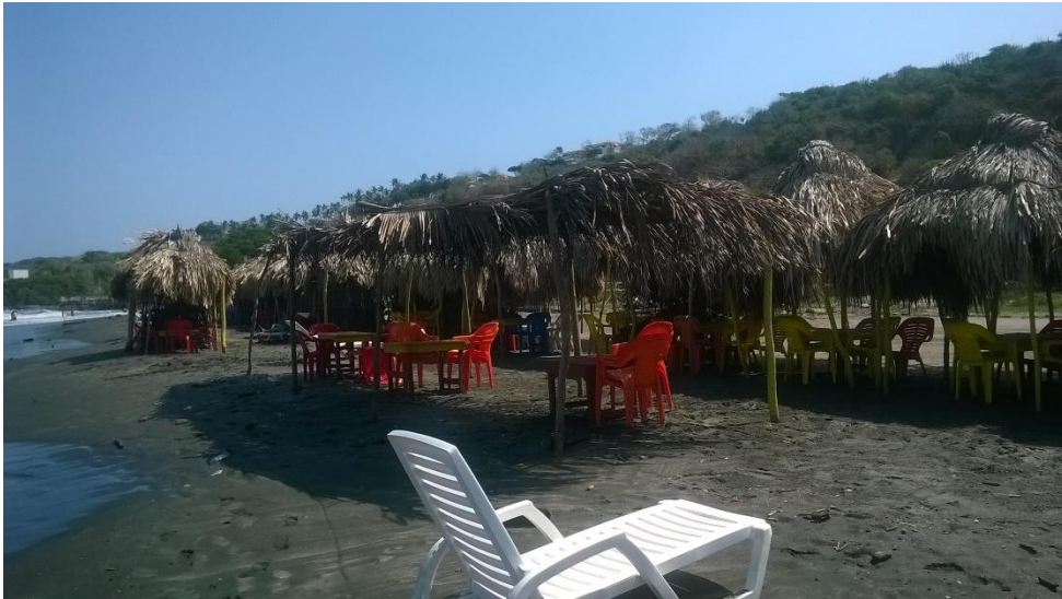
-Condición de instalaciones en Playa Sabanilla.
