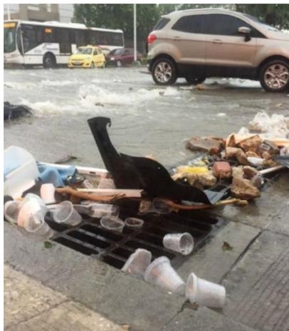
*Figura 16.* Rejilla de la calle 84 con carrera 51B en poca de invierno. Adaptado de “Indignante! Basuras taponaron rejillas en canalización del arroyo de la 84”. Por Zona cero. Recuperado de <http://zonacero.com/?q=generales/indignante-basuras-taponaron-rejillas-en-canalizacion-del-arroyo-de-la-84-72912>
