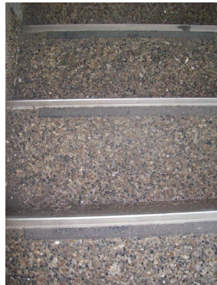
Foto 46. Escalones de Audiovisuales (Fuente: Elaboración propia)
