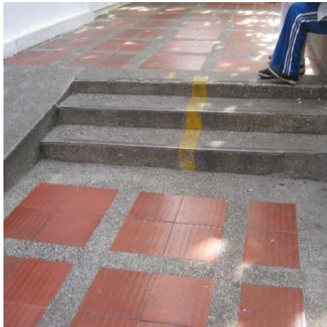
Foto 34. Escaleras Bloque 5-Bloque 7 (Fuente: Elaboración propia)
