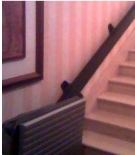
Foto 17. Hotel J.W. Marriot, Caracas. Plataforma elevadora (Tomada de: http://www.espanol.marriott.com/hotels/travel/ccsjw-jw-marriott-hotel-caracas/ )
