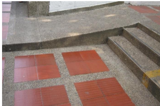
Foto 35. Rampa Bloque 5-Bloque 7 (Fuente: Elaboración propia)
