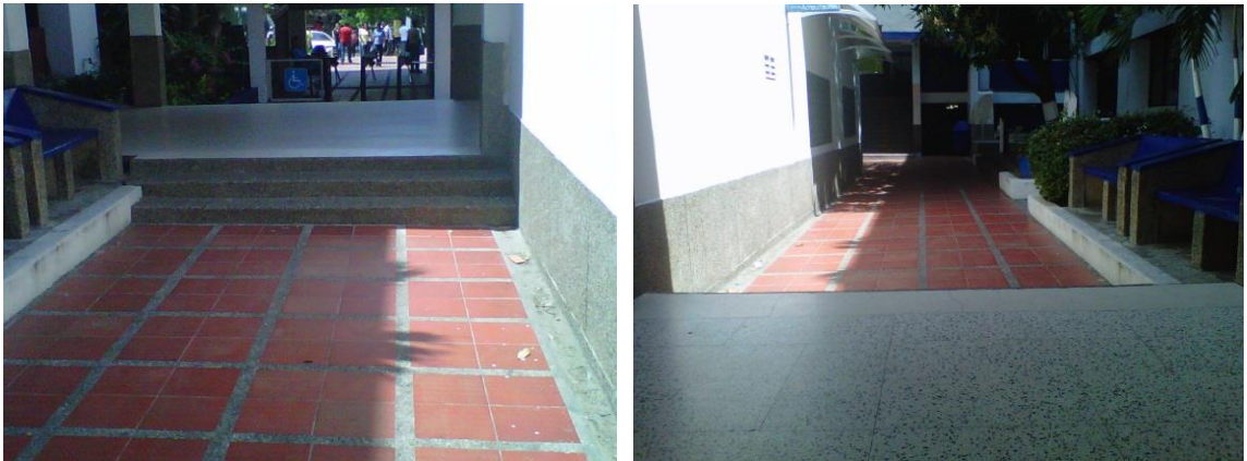
Fotos 56 y 57. Hall de acceso a Laboratorios de Física (Fuente: Elaboración propia)
