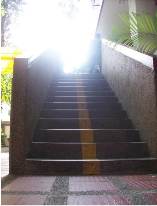
Foto 47. Escaleras de acceso a Biblioteca (Fuente: Elaboración propia)
