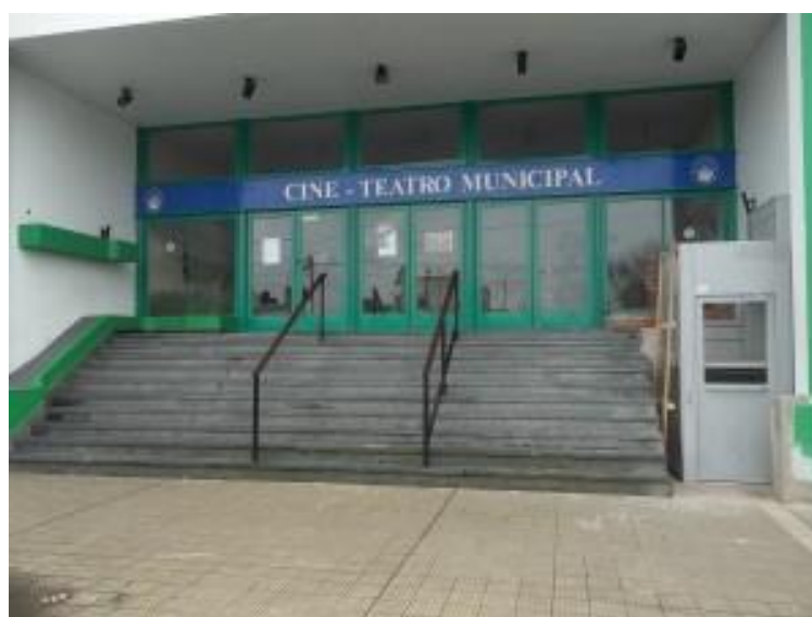
Figura 27. Ascensor para discapacitados en el cine teatro municipal de Ensenada
