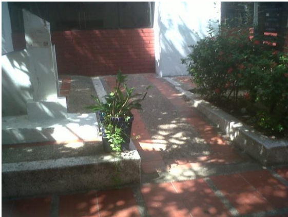
Foto 61. Rampa de acceso 1 (Fuente: Elaboración propia)
