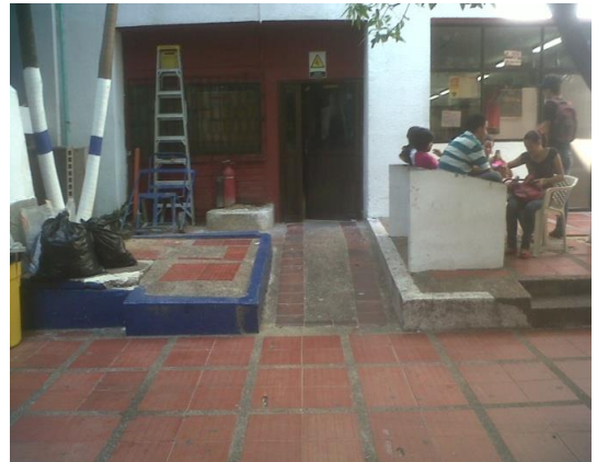
Foto 62. Rampa de acceso 2 (Fuente: Elaboración propia)
