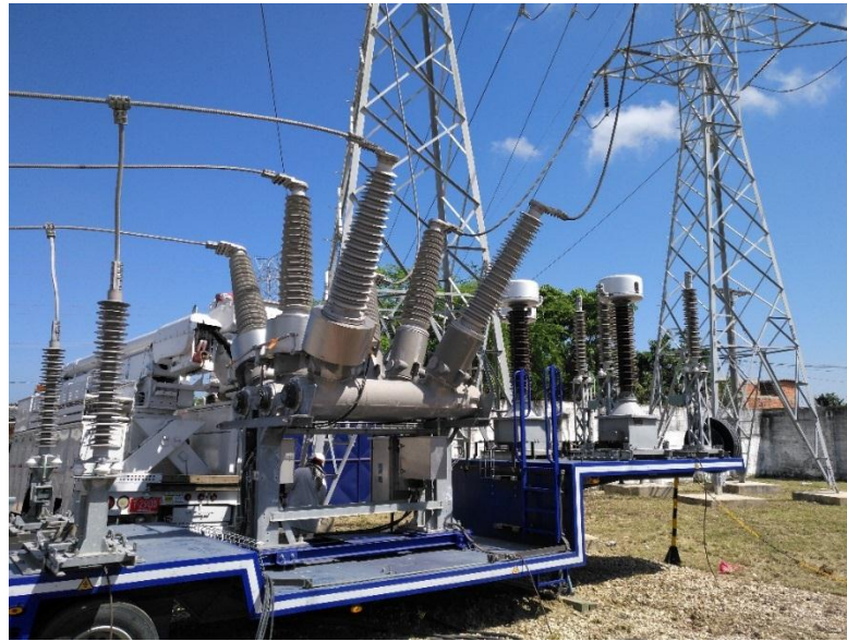
Figura 8.7 Subestación híbrida móvil en la subestación 20 de julio (Interrupción/Seccionador). Por Electricaribe S.A. E.S.P., 2017.
