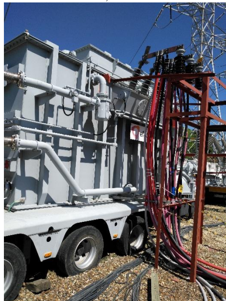
Figura 8.7 Subestación híbrida móvil en la subestación 20 de julio (Interrupción/Seccionador). Por Electricaribe S.A. E.S.P., 2017.
