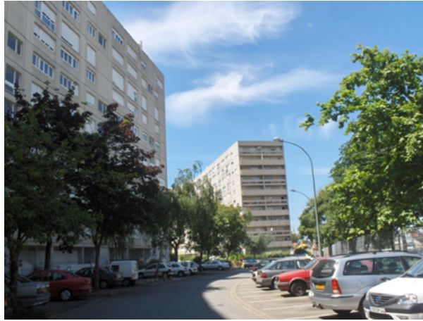
Figura 13. Malakoff Aval: edificios sin intervención en el año 2007.
