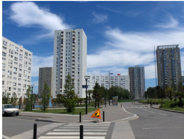
Figura 14. Malakoff Amont: edificios renovados. Año 2007.
