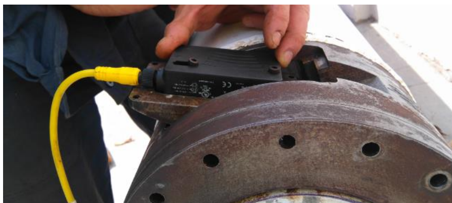
Figura 33 Disposición del sensor dentro de la junta.
