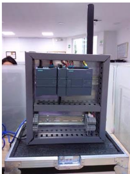
Figura 25 Estación remota construida.
