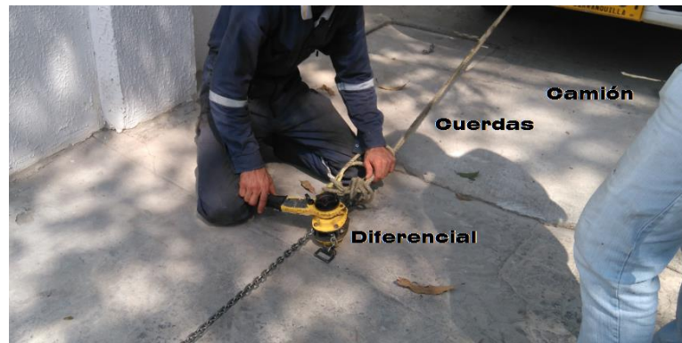
Figura 37 Instalación del diferencial utilizado en la prueba.
