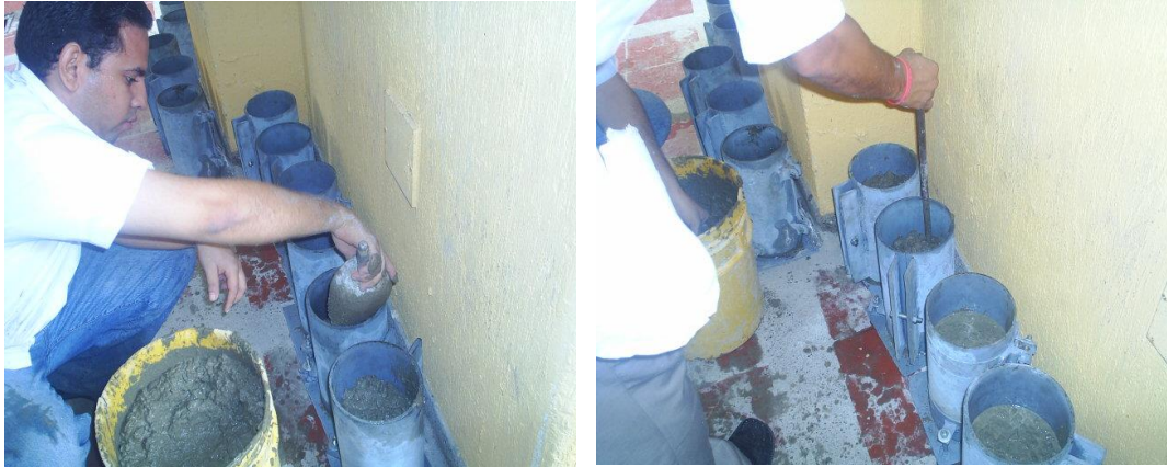
Figura 14. Llenado de moldes de 15x30 cm y compactación del concreto
