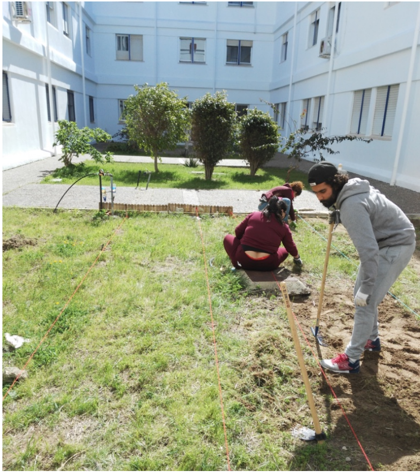
Figura 12. Trabajo en el terreno
