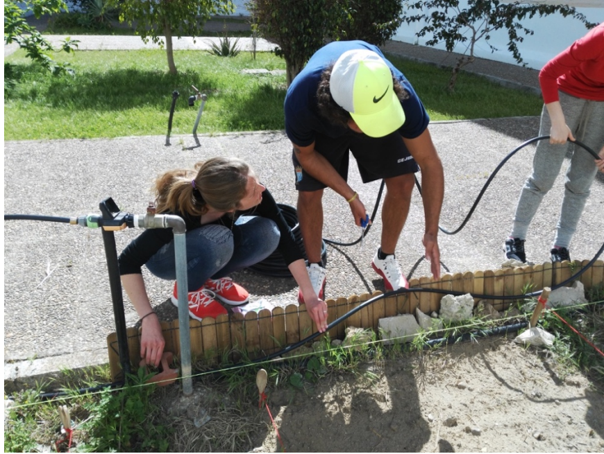
Figura 15. Instalación del sistema de riego por goteo.
