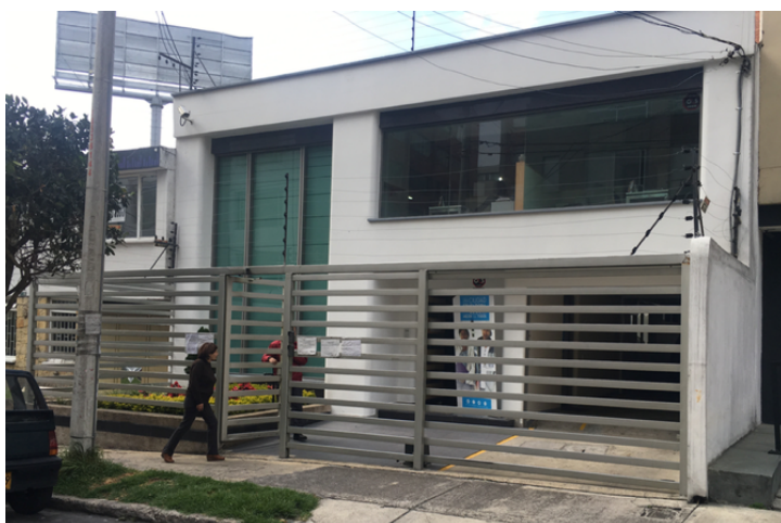
Figura 3. Fachada externa de la oficina de la Dirección Local de Educación de Usaquén
