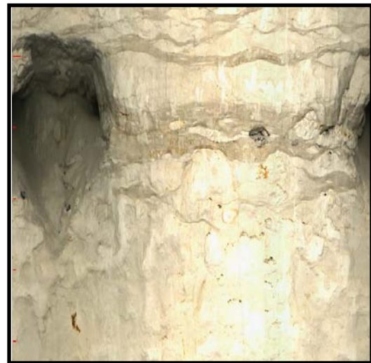
(d) Conduit ~ 15 cm high at 89.25 to 89.45 m AOD at a marl horizon,
