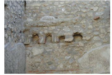
Fig. 10 Pompei, diverse forme degli alloggiamenti delle travi nelle murature: tonde o approssimativamente sgrossate. (foto degli autori, dicembre 2015)
