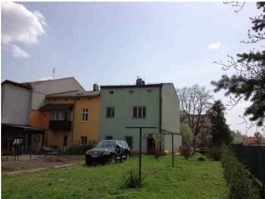
Obrázek č.7 – Pohled ze dvora na posuzovaný objekt
