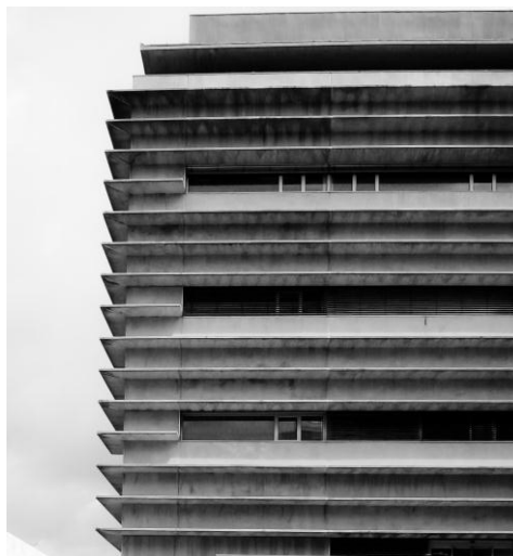
Figura 7 – Pormenor das estruturas de betão das fachadas do edifício C8.
