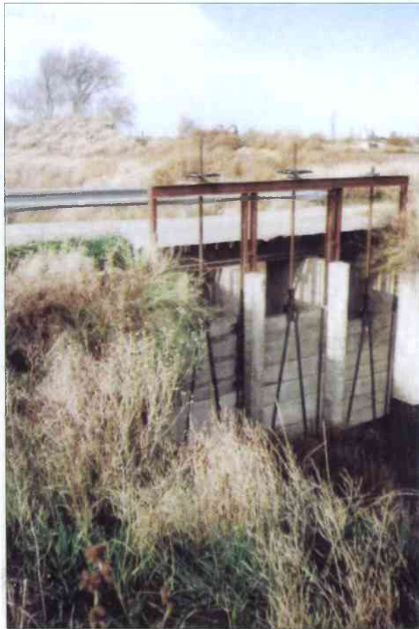
4.- Entrando a la zona de cultivos más intensiva, se comprueba la presencia de compuertas "a tornillo" que dividen las aguas.- (Luque)
