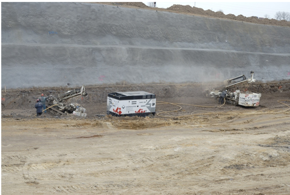
Obr. 8 - Hloubení vrtů a osazování hřebíků
