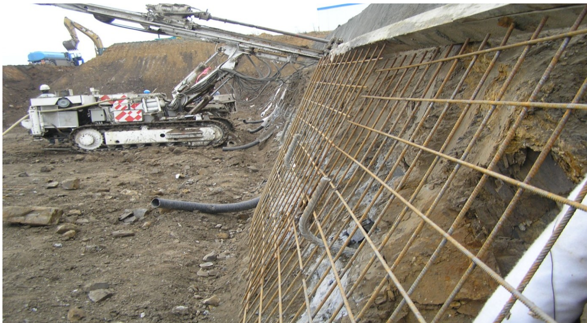
Obr. 7 - Zajištění jámy výztužnou sítí
