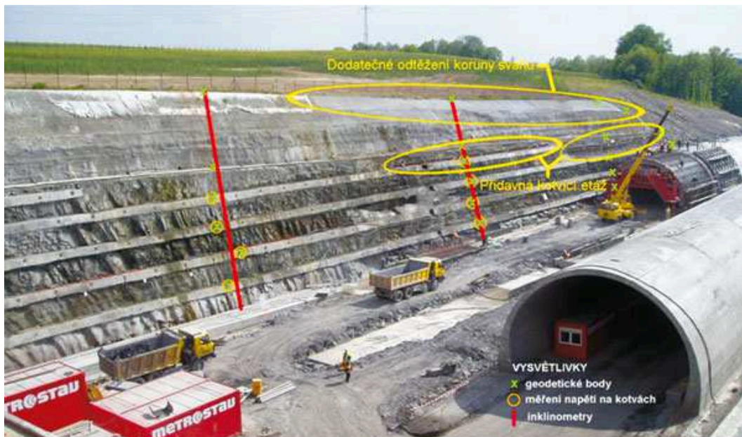
Obr. 10 Hloubená část jižního portálu a osazení monitorovacích prvků (zdroj: http://www.asb-portal.cz/inzenyrske-stavby/tunely/tunel-klimkovice-2-1000.html )
