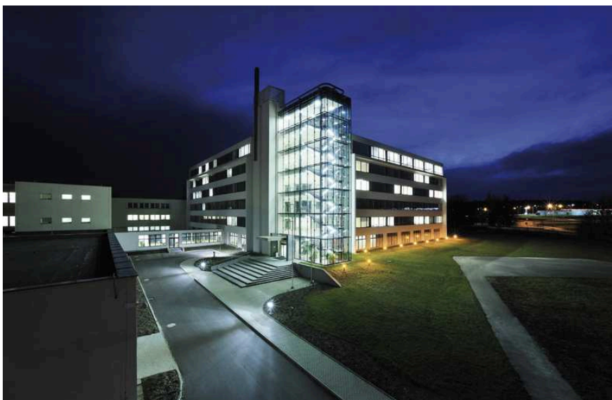
Obr. 1 Pavilon velkých poslucháren VŠB – TU Ostrava (zdroj: http://www.konstrukce.cz/clanek/pavilon-velkych-poslucharen-fast-vs-b-tu-ostrava/ )
