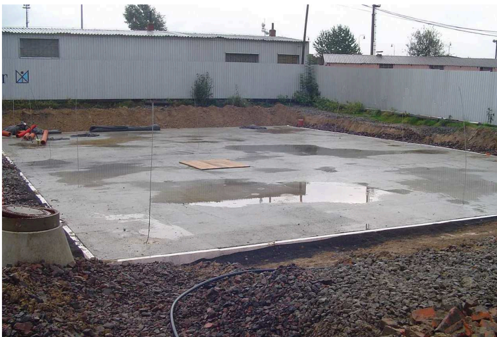
Obr. 14 Pohled na hotovou železobetonovou desku (zdroj: fotodokumentace investora)
