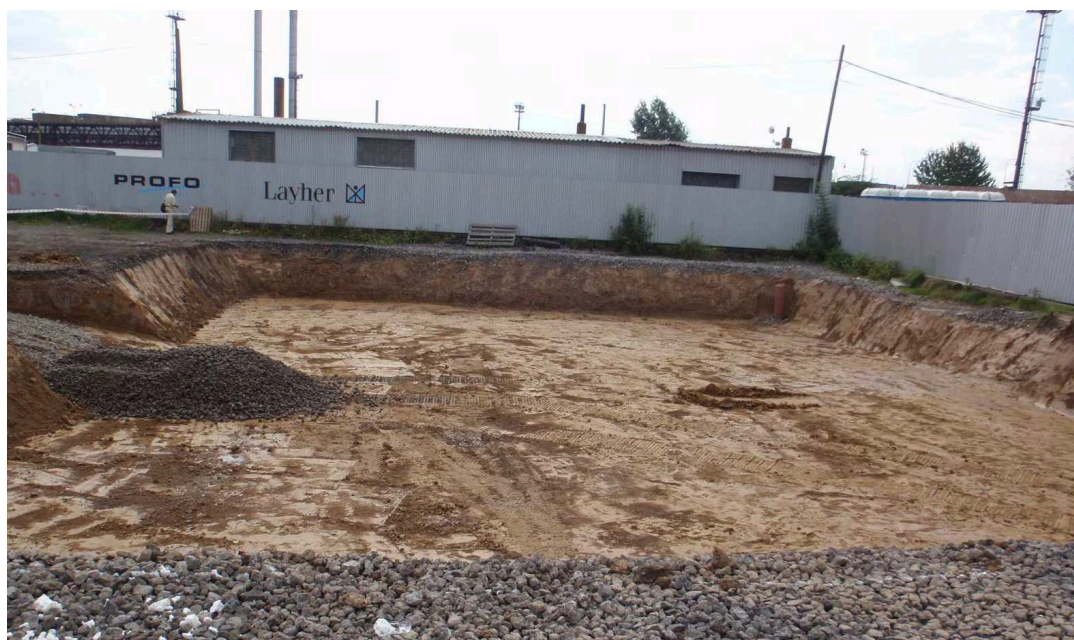
Obr. 12 Celkový pohled na základovou jámu (zdroj: fotodokumentace investora)
