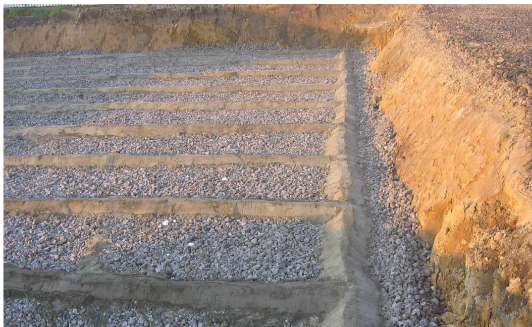
Obr. 13 Betonové náběhy (zdroj: fotodokumentace investora)
