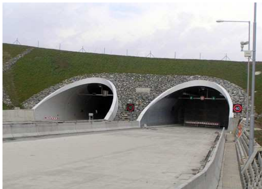
Obr. 8 Tunel Klimkovice na dálnici D47
