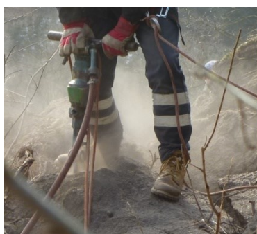
Obr. 23: Ruční vrtání vrtu, pomoci pneumatického kladiva [11].
