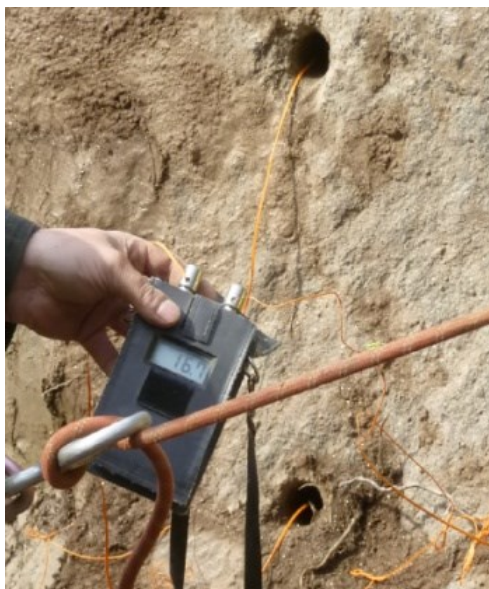
Obr. 26: Měření elektrického obvodu [11].
