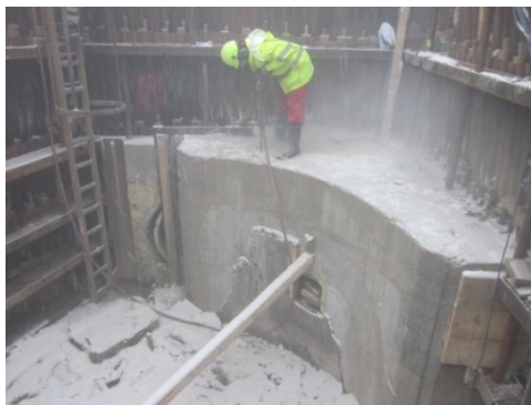
Obr. 28: Železobetonová patka [11].
