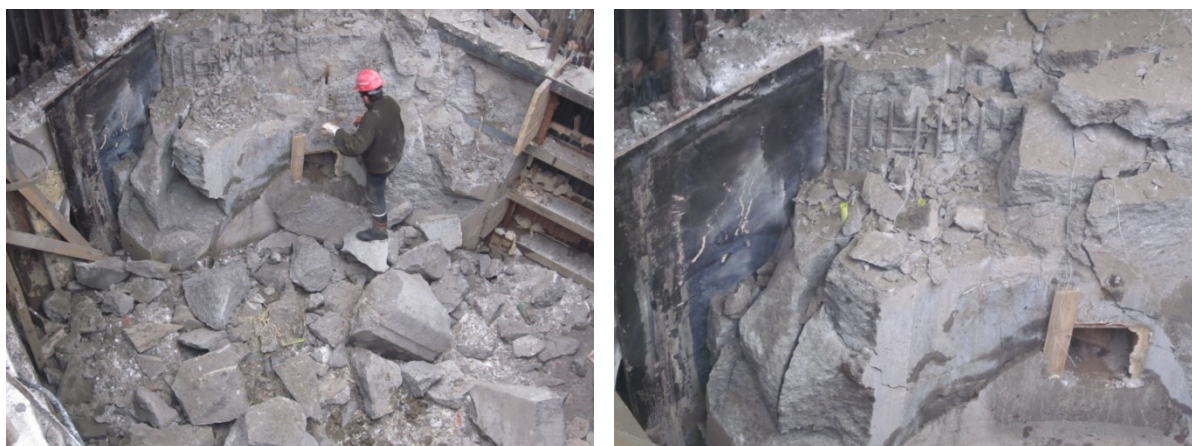
Obr. 30: Rozpojení ŽB bloku pomocí GBT[11].
