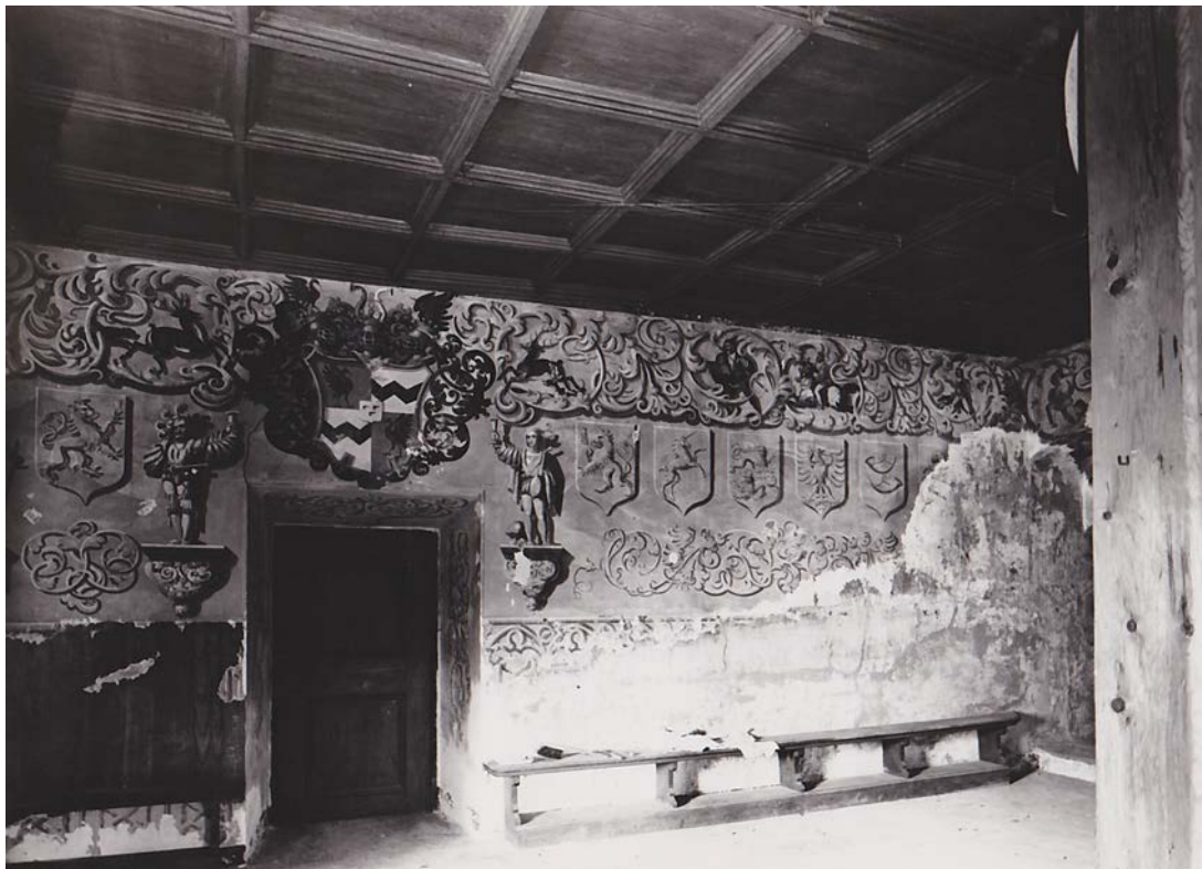
Abbildung 98: Ostwand im Jahr 1968 kurz vor der Freilegung der maximilianischen Malereien.
