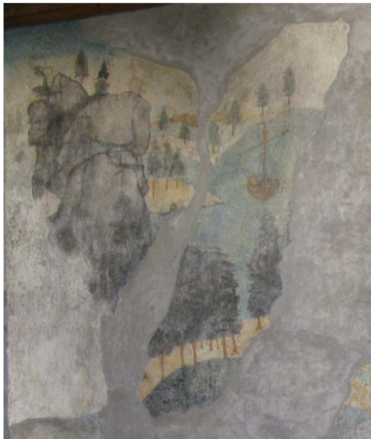
Abbildung 116: Linkes Fragment an der Westwand, Zustand 2012.
