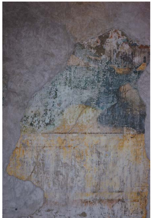
Abbildung 119: Rechtes Fragment an der Westwand, Zustand 1993.
