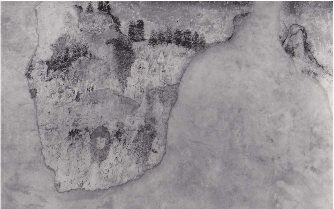
Abbildung 89: Bildfragment, rechte Seite der Südwand, Zustand 1968.
