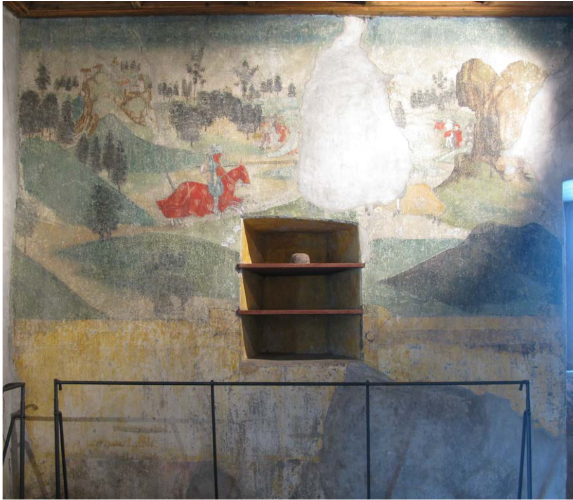
Abbildung 105: Linker Abschnitt der Nordwand, Zustand 2012.
