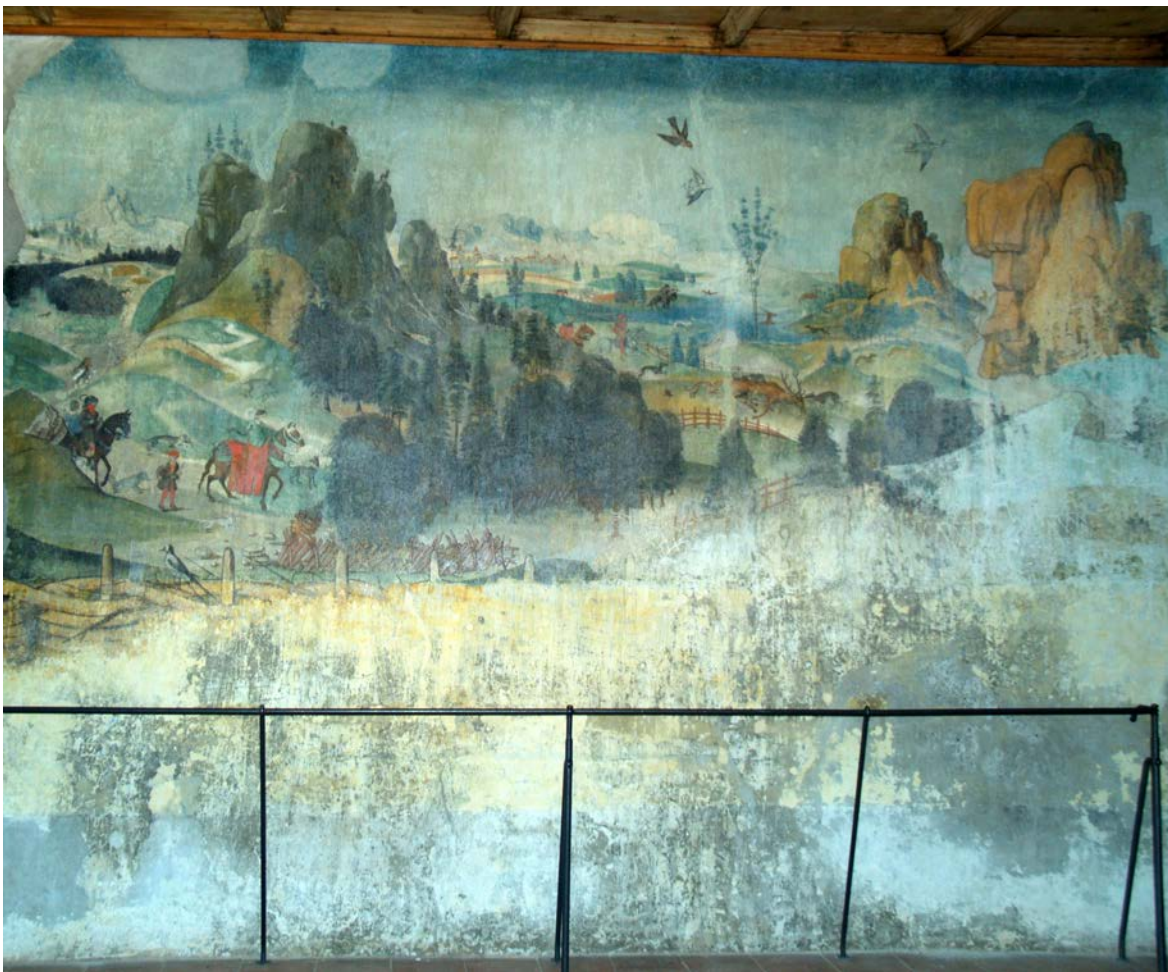
Abbildung 102: Rechter Abschnitt der Ostwand, Zustand 2012.
