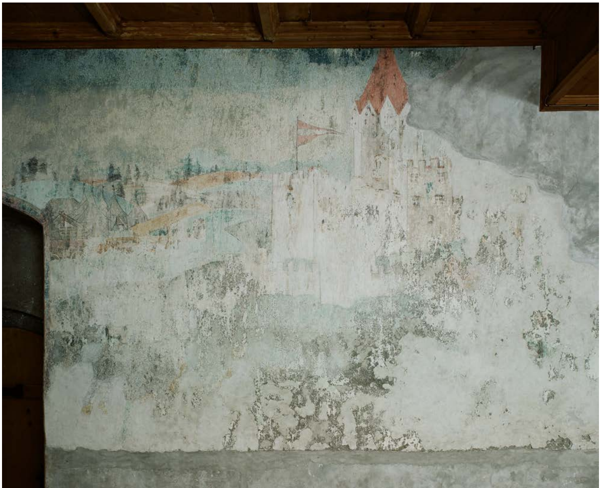
Abbildung 110: Belagerungsszene an der Südwand, Zustand 2010.
