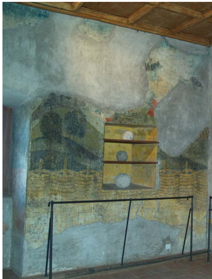
Abbildung 59: Flechtzaun rechts vom Fenster, Nordwand.
