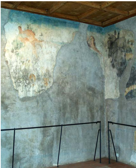
Abbildung 91: rechtes Fragment der Südwand und Südwestecke.
