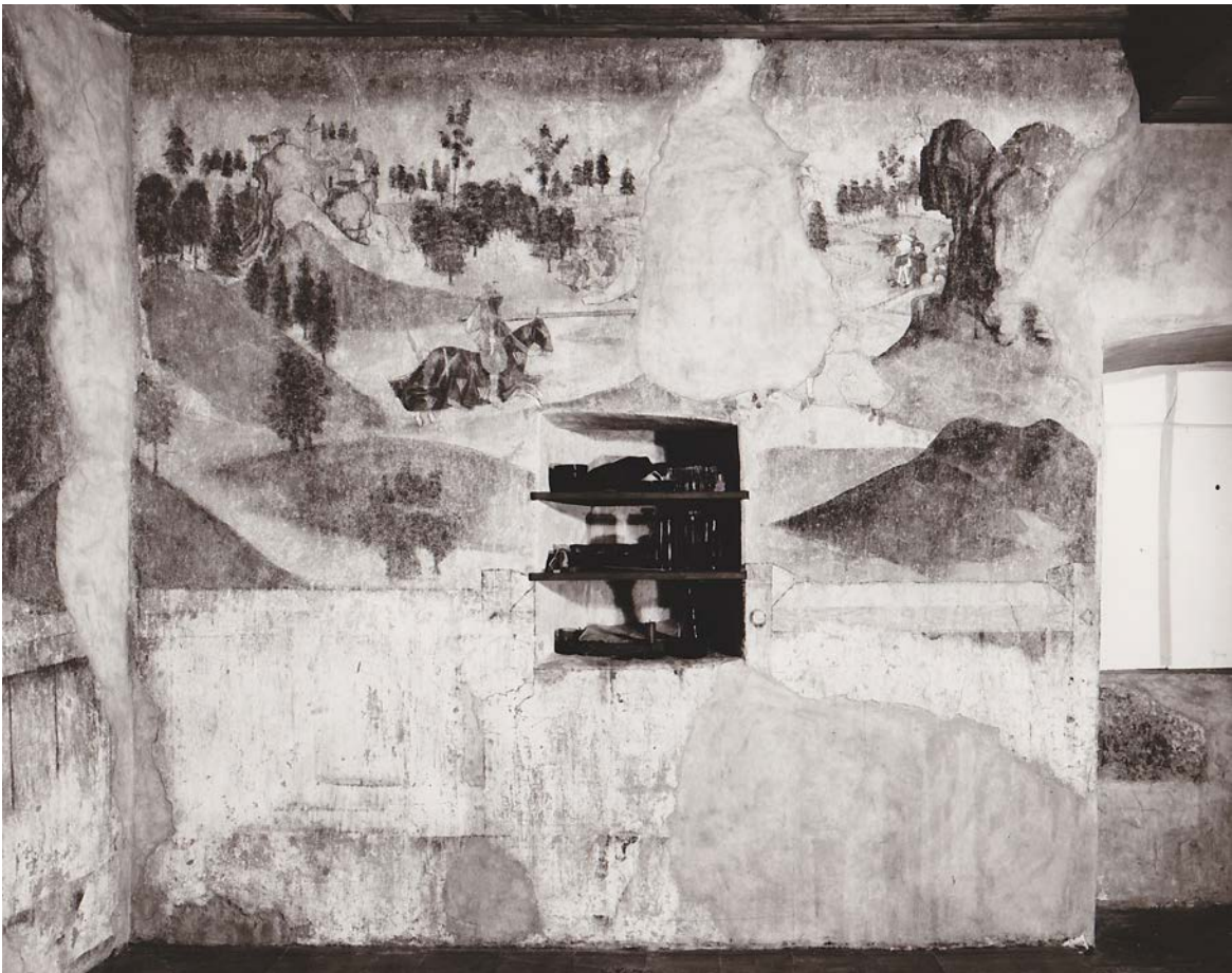
Abbildung 104: Linker Abschnitt der Nordwand, Zustand 1980.
