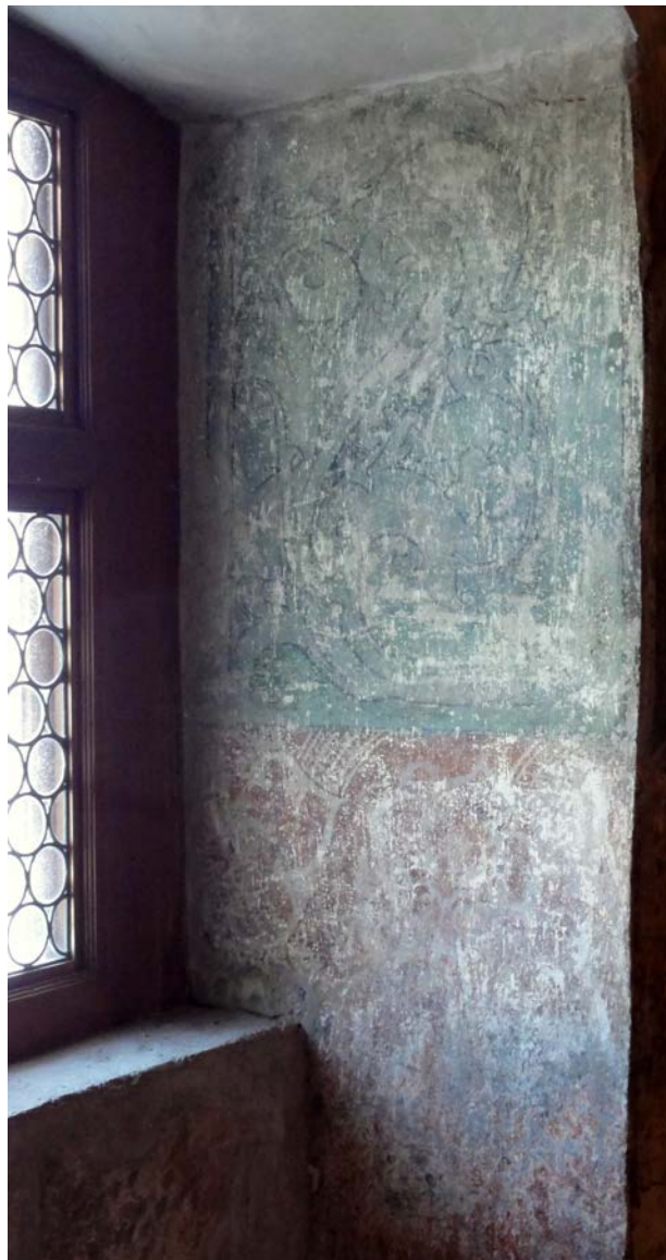
Abbildung 61: Laibung des Fensters an der Nordwand (Ausschnitt).
