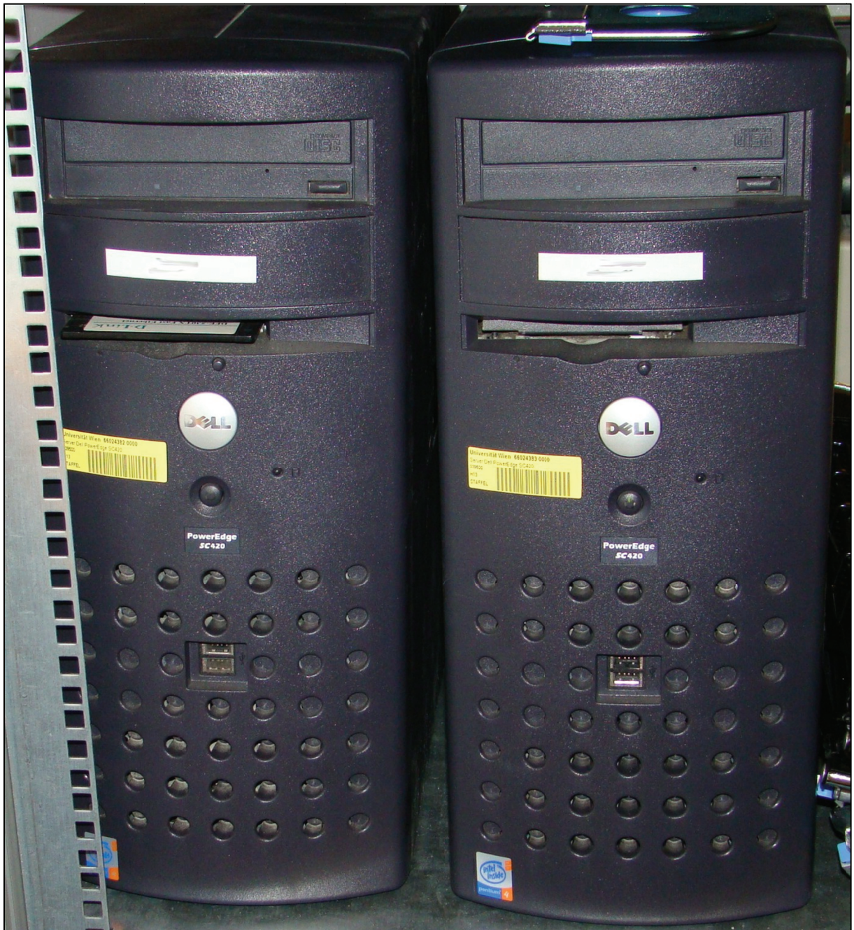
Abbildung 19: Foto von den alten EduWeaver Servern
