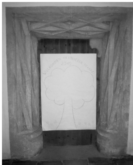
Abb. 37: Göß, ehem. Stiftskirche Hll. Maria und Margaretha, Langhaus, ehem. südliches Emporenaufgangsportal, 1510–1522.
