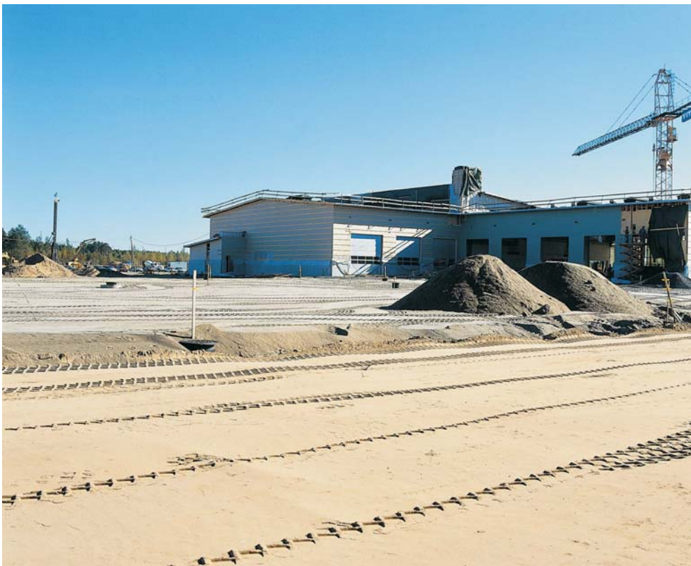
Kuva 6-4: Masuunihiekkaa on kehitetty ja hyödynnetty tuotemaisesti jo pitkään. Kuvassa masuunihiekkaa käytetään pihavalueen rakenteissa (Lähde: Rautaruukki Oyj, Marko Mäkikyrö).
