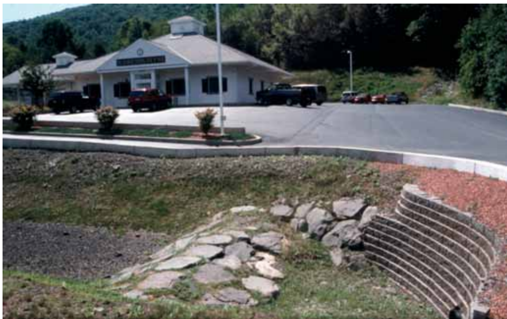
Kuva 13. New York Cityn vedenhankinta-alueella piha- ja kattovesiä kerätään muotoiltuun, normaalisti kuivana olevaan viivytysaltaaseen. Allas toimii samalla pankin sisääntuloväylän piha-aiheena. Marketville, New York, USA.
