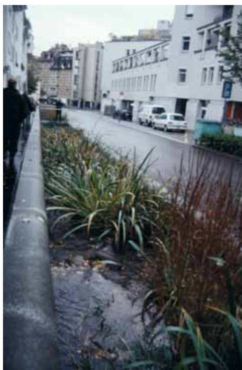
Kuva 19. Katualueelle avattu puro Zürichissä. Purossa elää taimenia.
