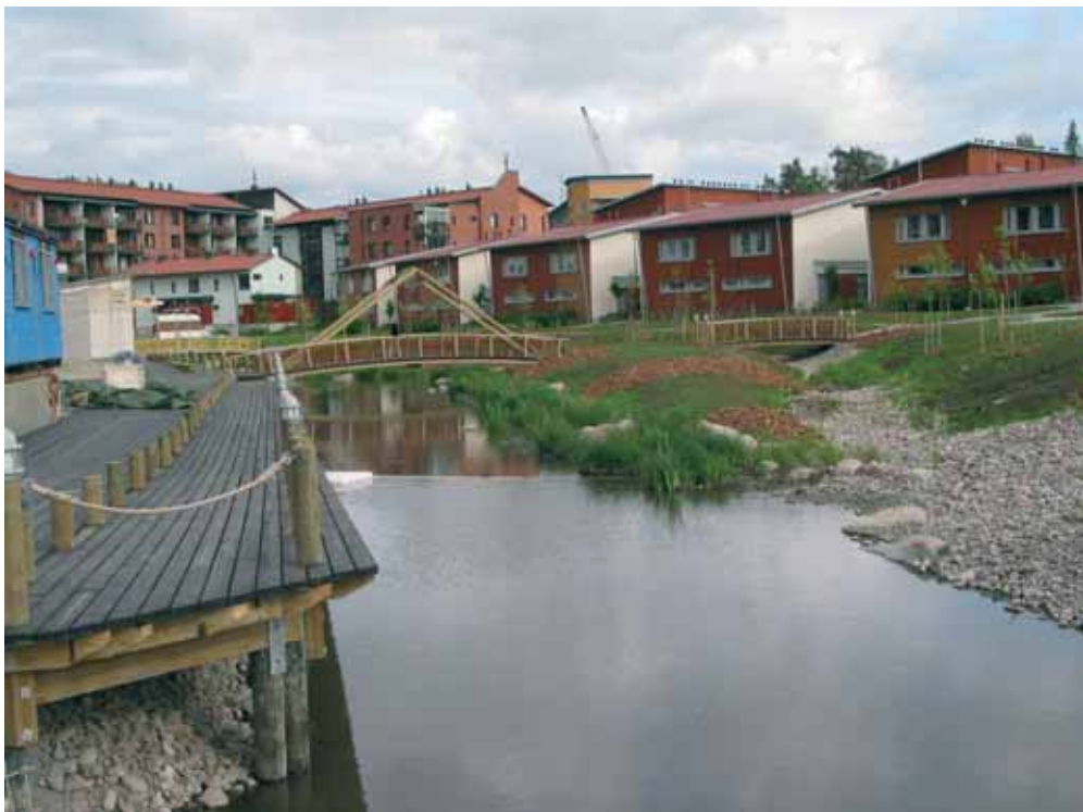
Kuva 21. Monikonpuroa on hyödynnetty Leppäviidan asuntoalueen vesiaiheena. Kuvan oikeassa laidassa on tulvauoma, jossa kulkee vettä vain ylivirtaamatilanteissa.
