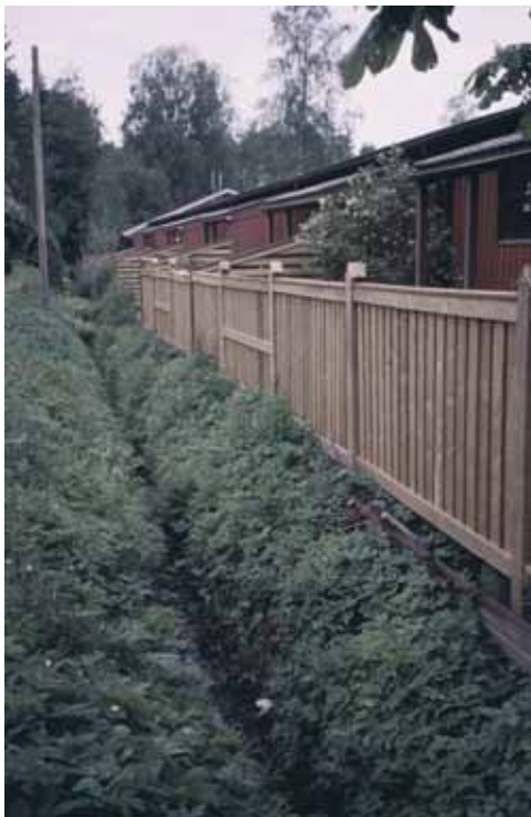
Kuva 25. Pientaloalueilla vesiä johdetaan avo-ojiin, joihin voitaisiin tehdä virtausta hidastavia kynnyksiä tai niitä voitaisiin kaivaa nykyistä mielenkiintoisemmiksi vesiaiheiksi. Kuva Rajakylästä.
