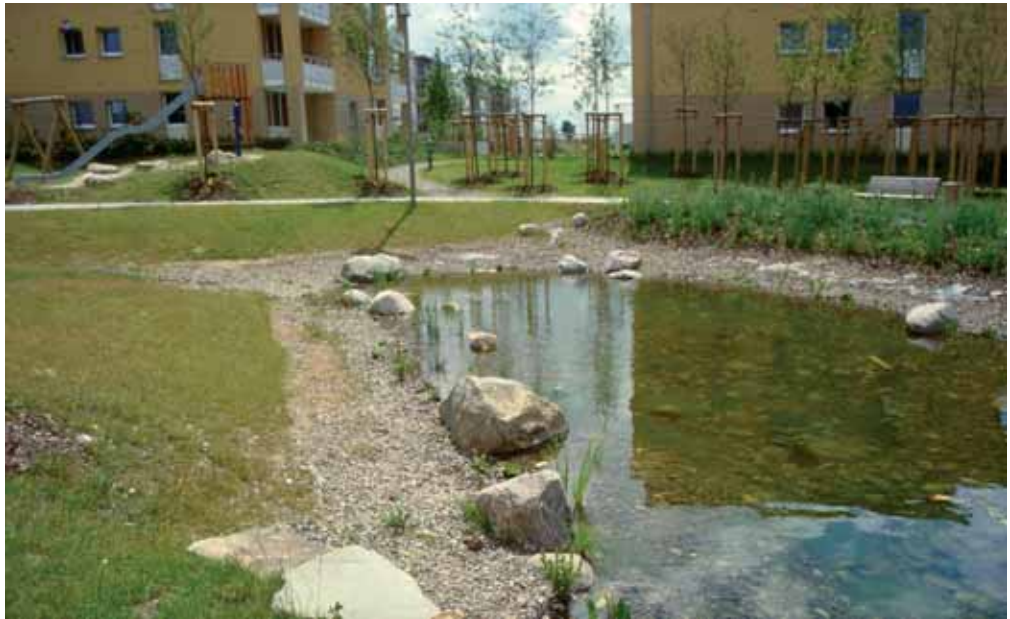
Kuva 10. Hannoverin Kronsbergin alueella kaikki sadevedet johdetaan maaperäimeytykseen ja viivytysuomiin, jotta alapuolisen puron virtaamasuhteet eivät muutu. Korttelipihojen vesiaiheet ja imeytysalueet on tehty monin eri tavoin.
