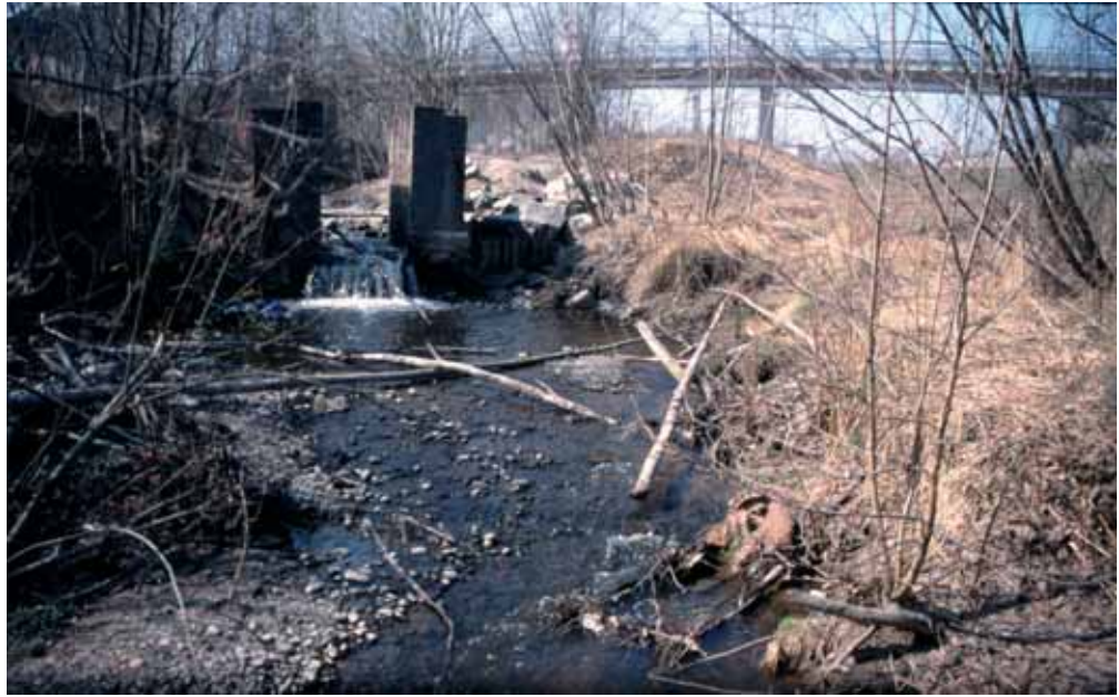
Kuva 41. Ojapuistonkosken myllypadon rakenteita tulisi kunnostaa kaloille nousukelpoisiksi säilyttäen kuitenkin joitakin rakenteita. Kosken alapuolella on luontaista kutusoraa.
