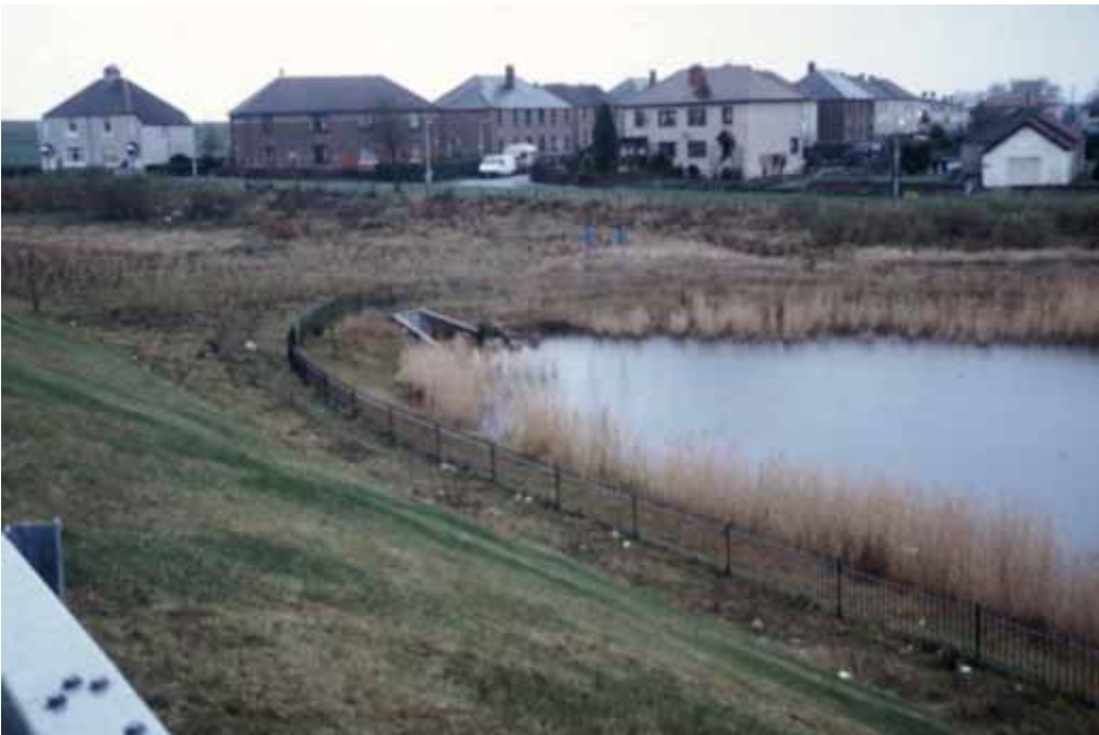
Kuva 15. Hulevesilampi toimii tievesien puhdistajana ja samalla asuinalueen vesi-aiheena. Etualalla tievesien imeytyskaista. Turvallisuutta pyritään lisäämään viitteellisellä aidalla. Dunfermline, Skotlanti
