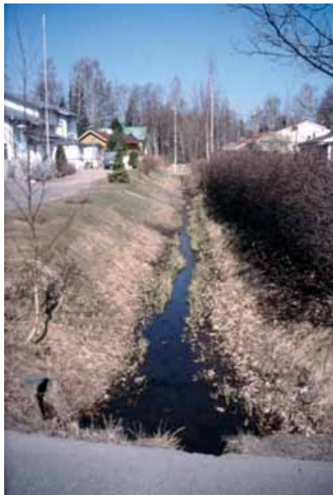
Kuva 36. Vesalassa koillisesta virtaavaan lähteelliseen sivu-uomaan on kehittynyt itsestään kapea alivesiuoma. Kuvan etualalle voitaisiin tehdä muutaman neliömetrin suuruinen uomalaajennus.
