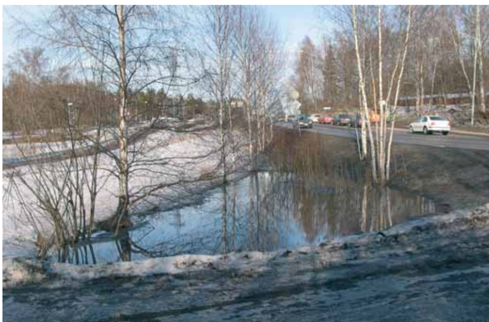
Kuva 17. Sulamisvaiheessa lähtevät ensin äkillisesti liikkeelle liukoiset aineet, kuten tiesuola. Kuva Itävälän varresta, missä ajoradan ja kevyen liikenteen väylän välinen painanne toimii sulamisvesien laskeutusaltaana.
