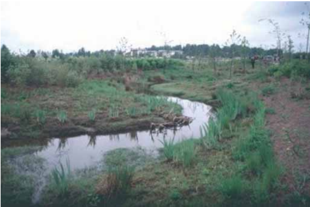
Kuva 8. Viikinojaan on linjattu mutkitteleva alivesiuoma ja uoman yhteyteen on rakennettu tulvatasanne.
