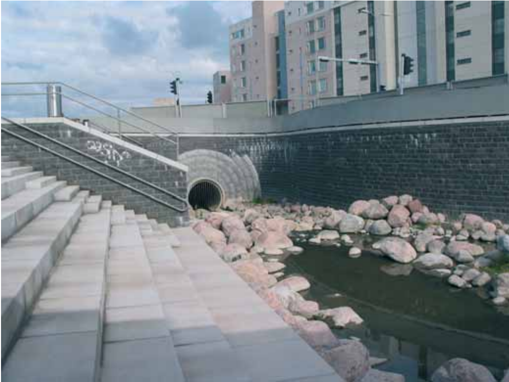
Kuva 20. Monikonpuroon on tehty kapea alivesiuoma ja torin koskiaihe muurien sisään rakennettuun avouomaan. Kuvassa olevasta Ratsutorin koskesta on tavattu yksittäisiä taimenia, mutta pysyvämpää taimenien oleskelua ei ole todettu.
