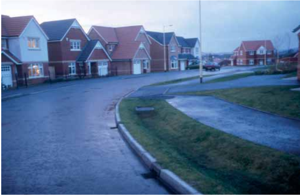
Kuva 14. Kadunvarsipainanne kerää katuvesien epäpuhtauksia. Ylivuotokaivojen kannet ovat pohjan tasoa ylempänä. Suomen oloissa painanteisiin johtavien aukkojen tulee olla avonaisempia tukkeutumisen estämiseksi. Dundee, Skotlanti.
