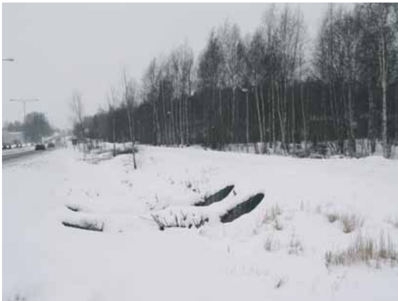
Kuva 32. Mellunkylänpuro alittaa putkessa Itäväylän. Kevyen liikenteen väylän takana on tilaa puron tulva-alueelle ja sen eteläpuolella mahdolliselle pumpaamalla hoidettavalle huoltoaseman hulevesien käsittelykosteikolle
