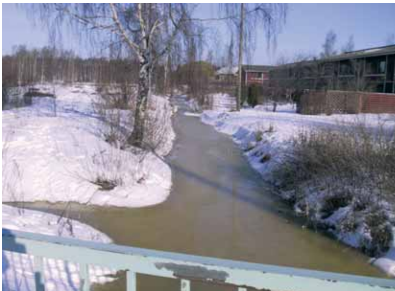
Kuva 34. Latvaosat ovat suoraa ojaa, mutta mutkittelulle olisi hyvin tilaa paltaviljelyalueen kohdalla. Alivesiuoma voisi olla kapea ja se voisi mutkitella sekä viljelyalueella että tonttien reunassa.
