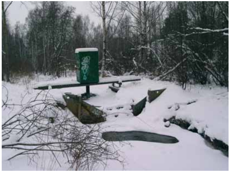
Kuva 46. Puron alaosassa oleva mittapato tulisi purkaa, koska se on nousueste kaloille.
