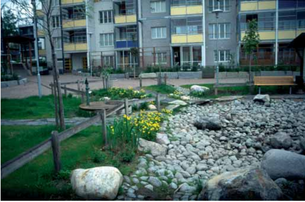
Kuva 7. Viikin ekologisella asuinalueella sadevesiä johdetaan imeytyspainanteisiin.
