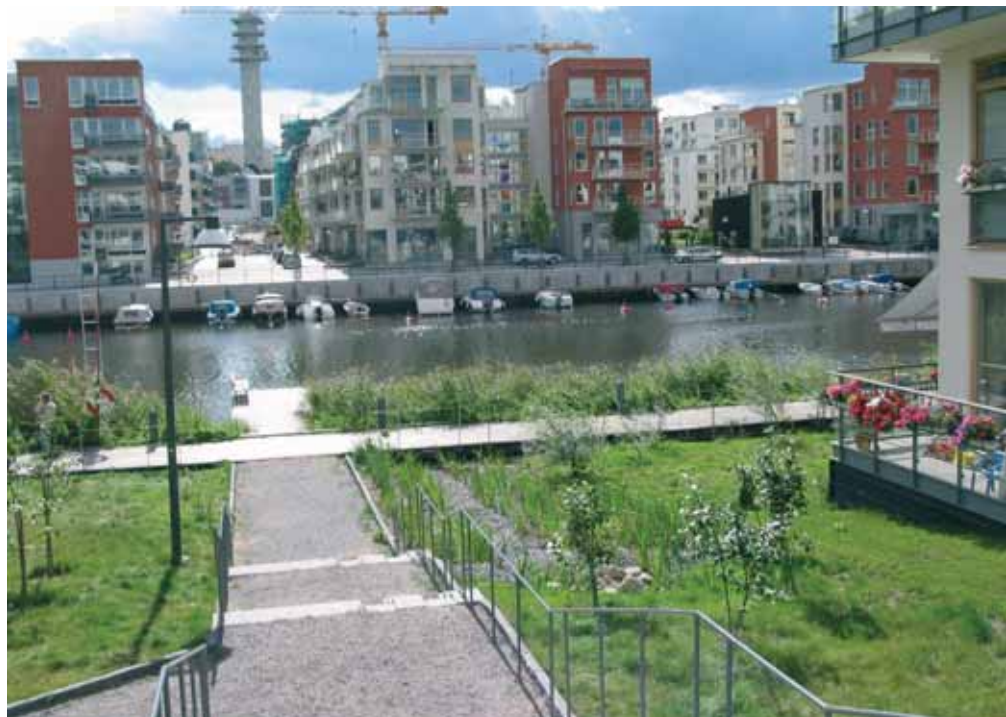
Kuva 16. Uudella asuntoalueella sadevedet johdetaan etualalla olevalle imeytysalueelle, Hammarby Sjöstad, Tukholma.
