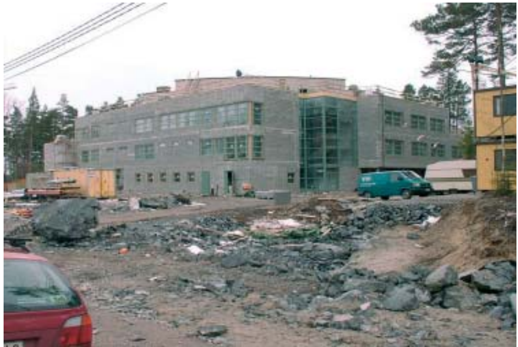
Kuva 25. Ala-aste ja päiväkotito rakennusvaiheessaan Vuosaaren Aurinkolahdessa.
