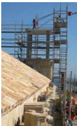
Pilares cuerpo 2º torre S
