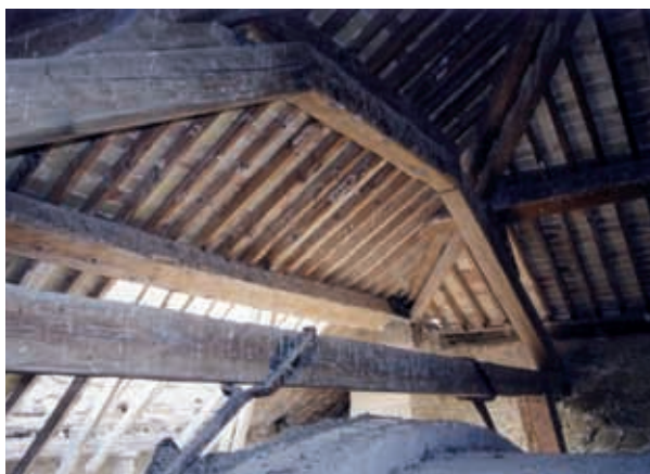
Fig. 03. Vista del interior de la cámara bajo cubierta (ca. 1998)
