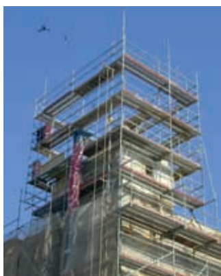
Desmontaje torre sur 2003
