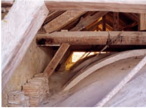
Cámara del tradós una vez limpiada, 2004
