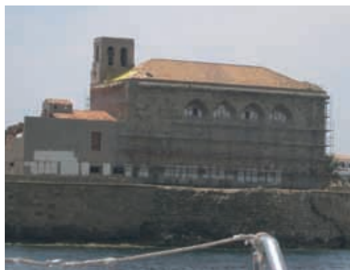
Vista norte de la iglesia con el montaje del andamio 2003
