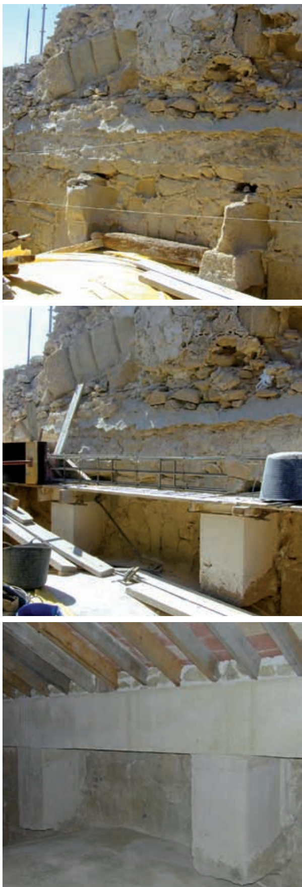
Fig. 08. Trasdós del tímpano antes, durante y tras la intervención (ca. 2004-05)
