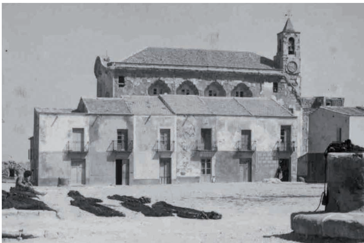
Fig. 14. Fotografía de la fachada sur de la iglesia desde la plaza Carolina (ca. 1940)
