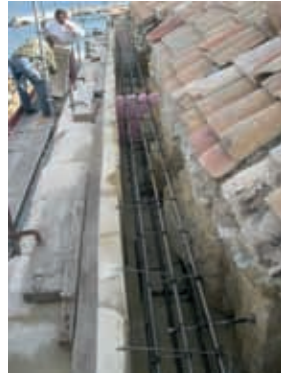
Armaduras zuncho de atado
