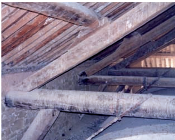
Fig. 06. Vista del interior de la cámara bajo cubierta (ca. 1998)
