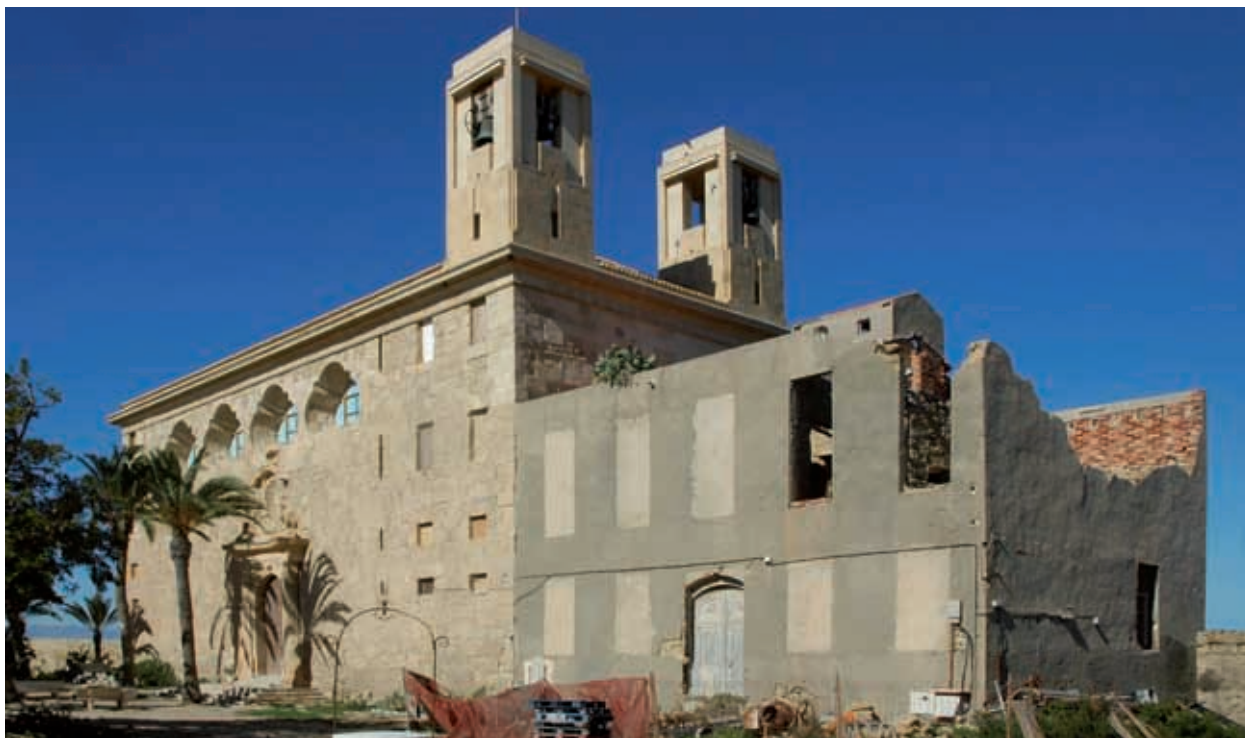
Fig. 17b: Iglesia después de la intervención de restauración (2012)
