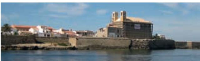
Vista del lado norte con la iglesia tras el abandono de las obras, 2009
