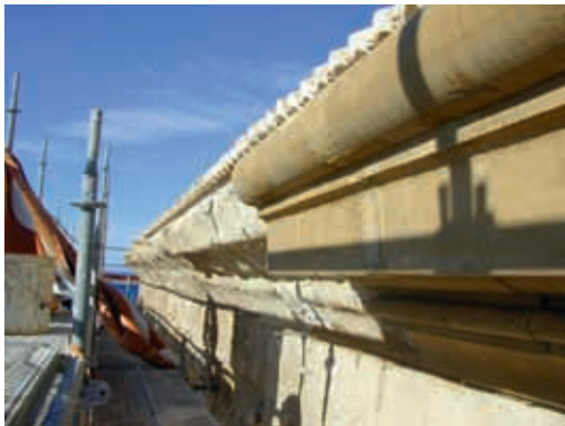
Ejecución del recrecio de la moldura sur, 2004
