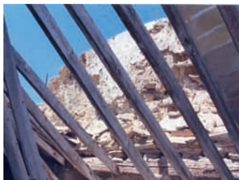
Parte posterior del tímpano de la fachada oeste, 1998
