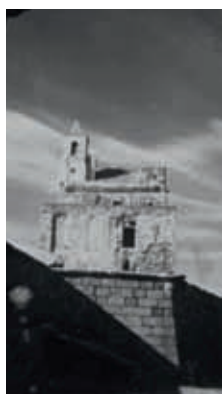
Iglesia y dos torres 1940
