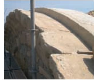
Refuerzo posterior moldura
