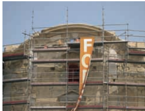
Tramo central moldura ya ejecutada, ca. 2007
