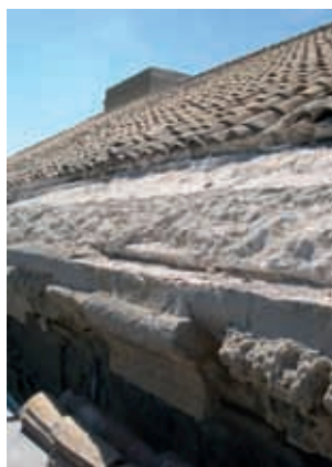
Cornisa norte con piezas enteras
