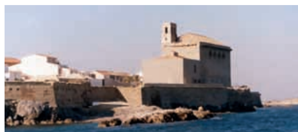
Murallas e iglesia del lado norte al inicio de las obras, ca. 1996-98
