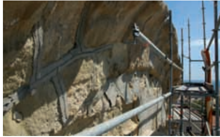
Detalle de la moldura oeste al inicio obras 2003
