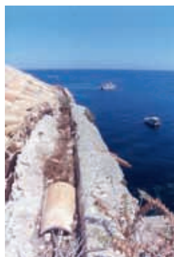
Canalón de cubierta, 1998
