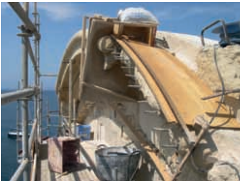
Proceso de recreado moldura con anclajes y plantilla
