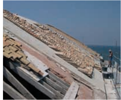
Sustitución tablero cerámico cubierta, 2007
