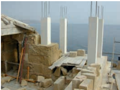
Levantamiento de pilares cuerpo 1º torre norte, 2005
