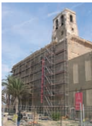
Fachada sur con andamio, 2003
