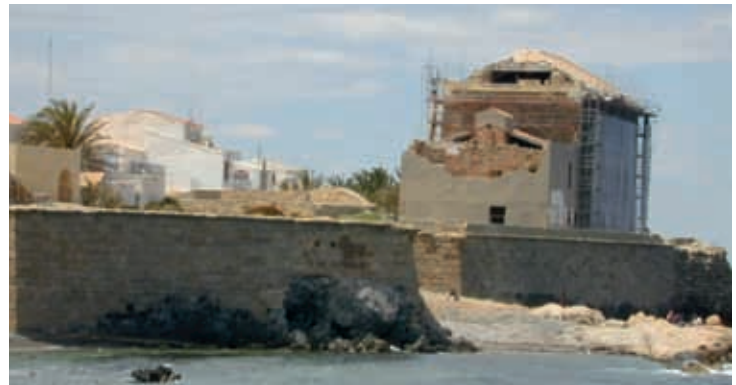
Iglesia con las torres desmontadas, 2004
