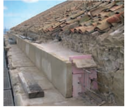
Hormigonado zuncho de atado y arriostramiento
