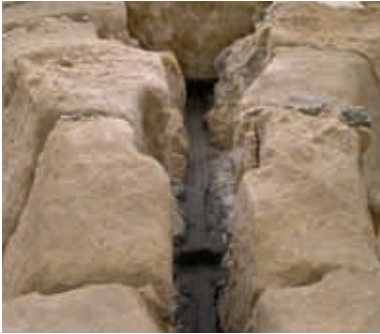
Refuerzos de hierro entre rosetones, 2006
