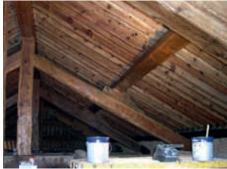
Imprimaciones en estructura de madera, 2006-07
