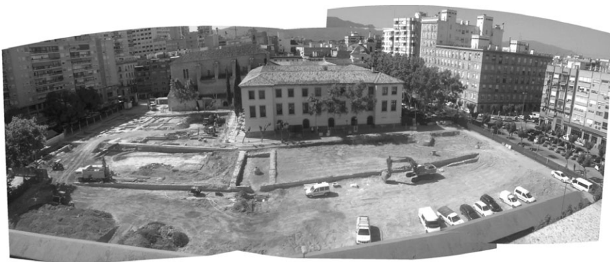
Fig. 1. Vista panorámica de los inicios de la excavación, mayo 2009 (Fuente: autores).
