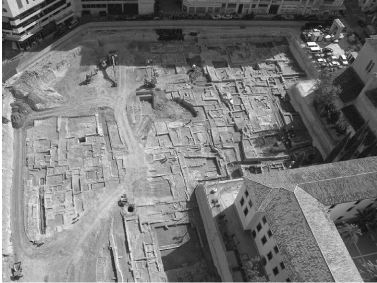
Fig. 9. Vista aérea de la excavación, septiembre 2009 (Fuente: Ana Pujante).
