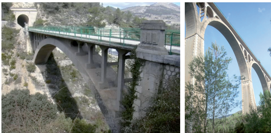
FIGURA 9. Puentes del ferrocarril Alacant-Alcoi
