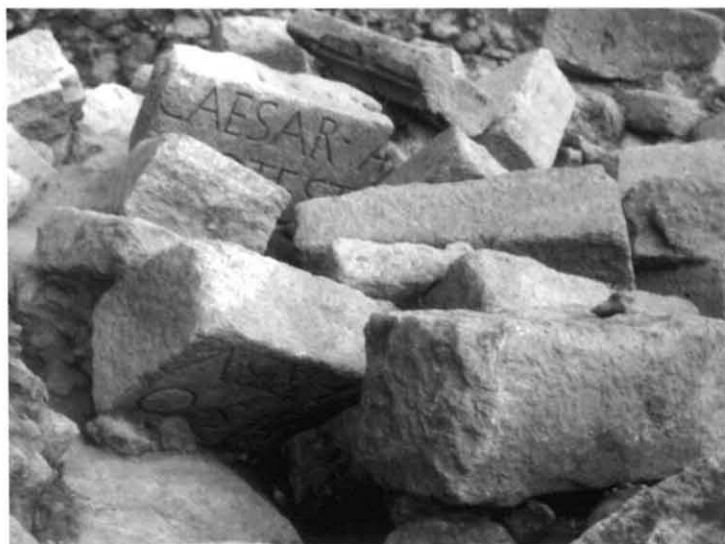
Figura 7. Derrumbe de sillares en El Reguerón.
