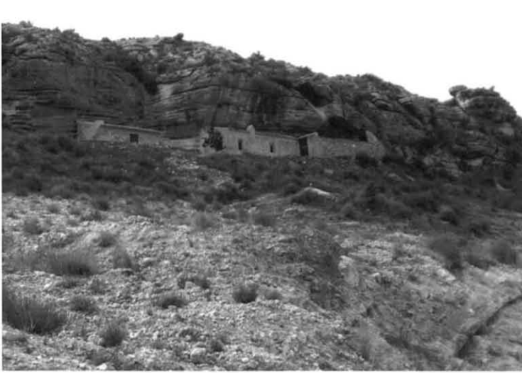
Figura 20. Casa semirrupestre rehabilitada en la ladera septentrional.
